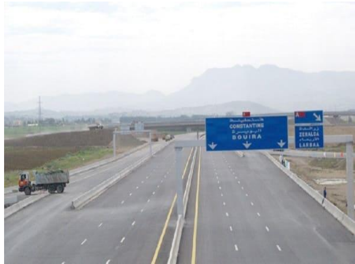
Figure 1.4 Autoroute Est-Ouest : le dernier tronçon finalisé avant la fin de l'année 2022
