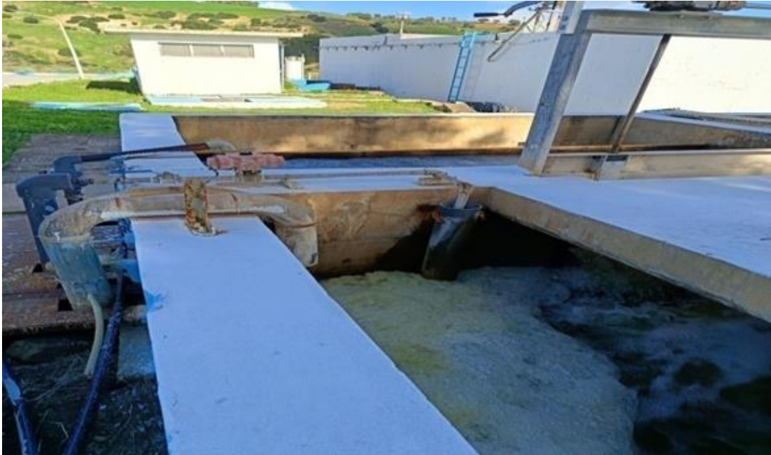
Figure II.1 Etape de traitement de l'eau par coagulation
