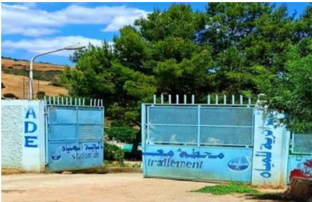
Figure I.3 Entrée de la Station de traitement des eaux Hammam Debagh
