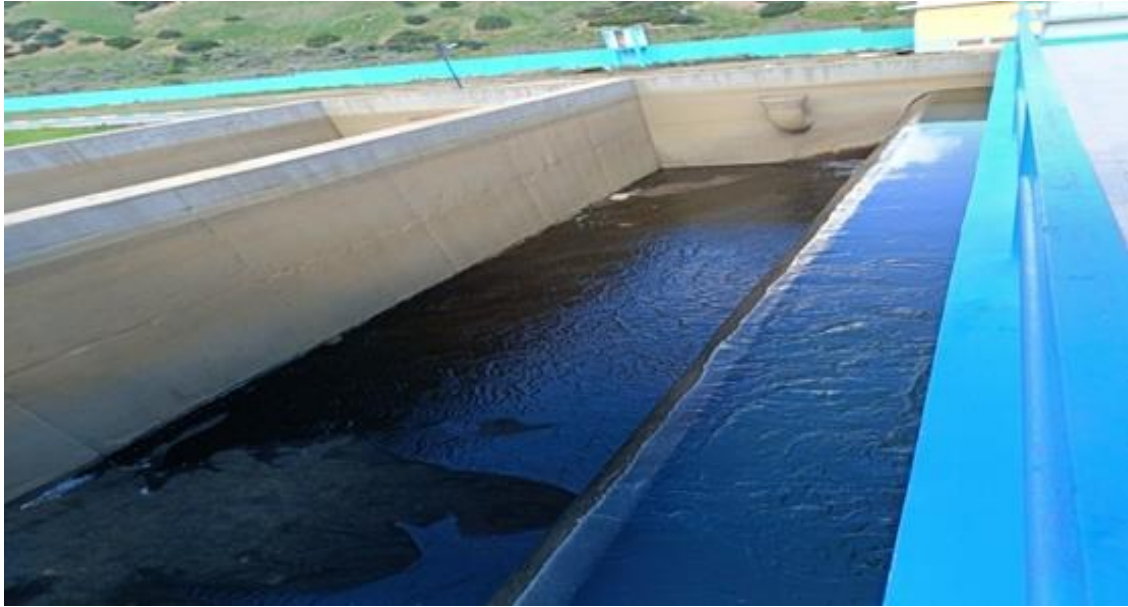
Figure II.3 Filtre à sable
