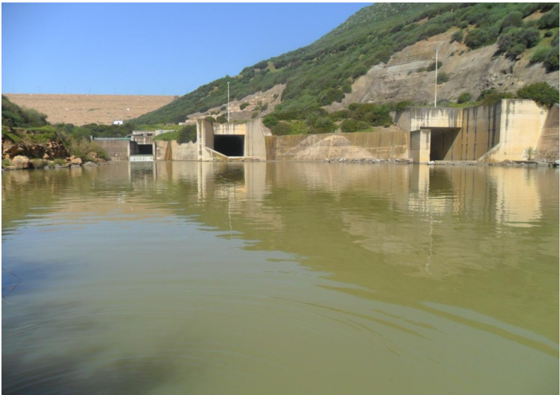
Barrage Hammam Debagh (naima,2014)
