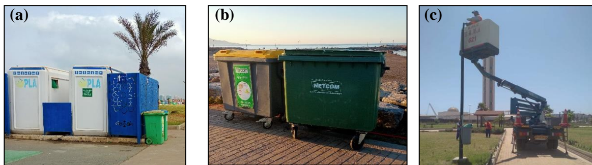
Figure V-8: Blocs sanitaires en PVC (a). Les poubelles nettoyées par NETCOM (b). Maintenance des poteaux de l'éclairage public (c). (Source : Auteur, 2022)
