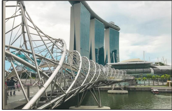
Figure I-16: Le pont à double hélice dans la promenade
