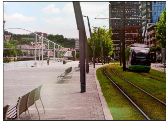
Figure I-7: La ligne de tramway le long de la promenade
