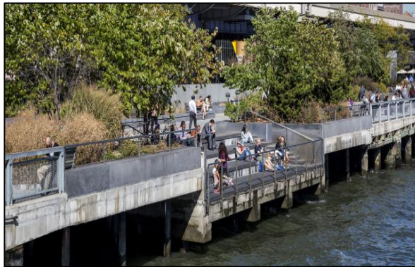
Figure I-12: Des marches à proximité de l'eau
