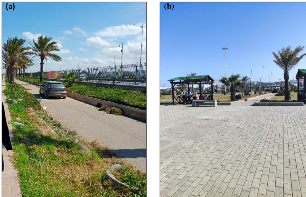
Figure V-73: Le béton bitumineux dans la route de servitude (a). Le revêtement modulaire dans la promenade (b). (Source : Auteur, 2023)
