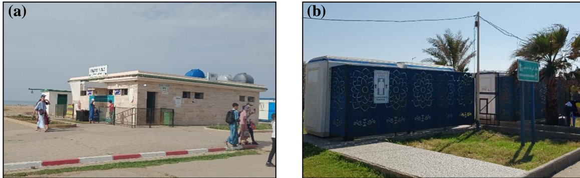
Figure V-18: Bloc sanitaire en dur (a). Blocs sanitaire en PVC (b). (Source : Auteur, 2023)
