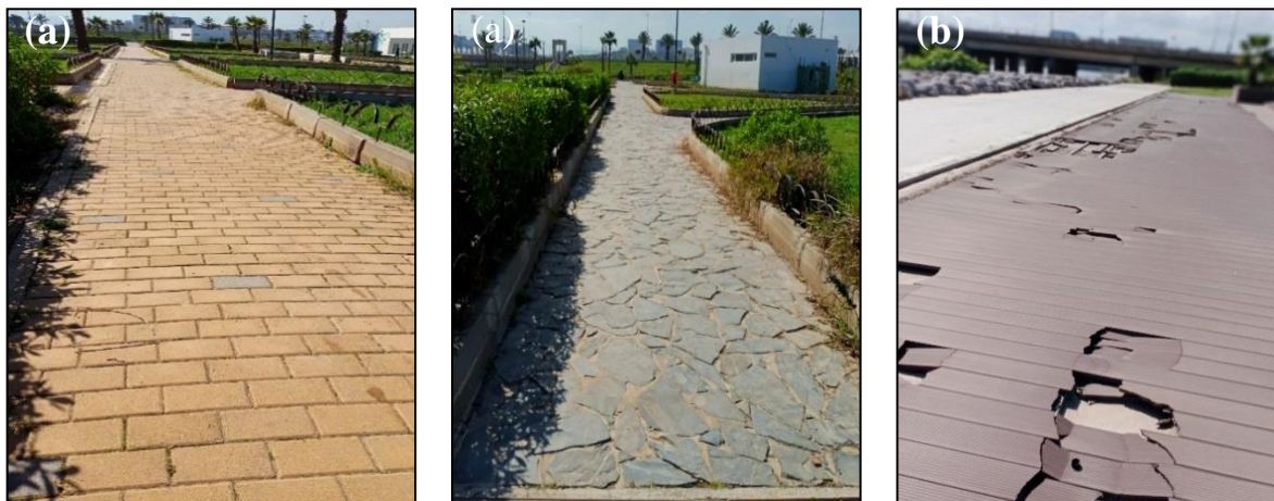
Figure V-6: Le pavage de la promenade (a). Le revêtement du sol par les panneaux de PVC (b). (Source : Auteur, 2019)
