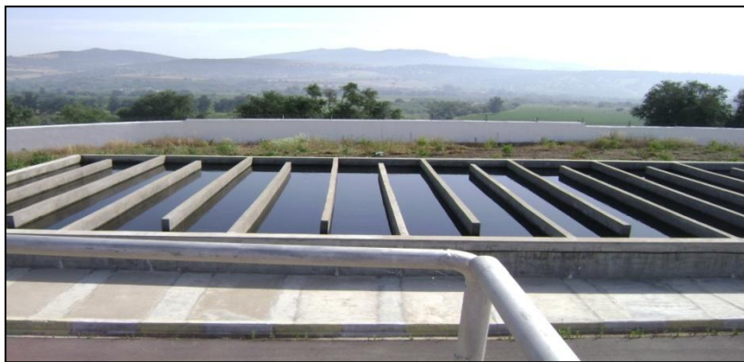
Figure 16. Bassin de désinfection. (STEP Guelma, 2008).
