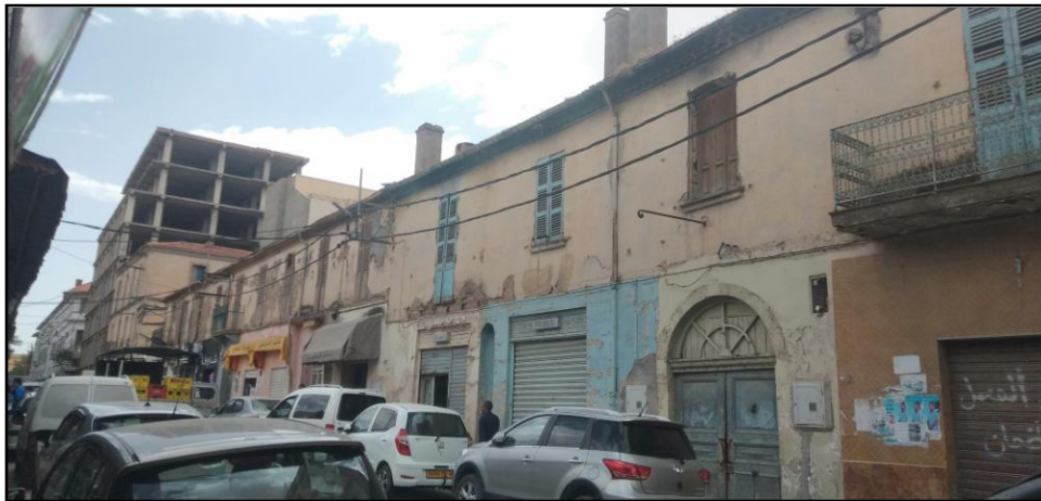
Photo IV.8. Locaux fermés dans une "Harat" en situation de litige.
