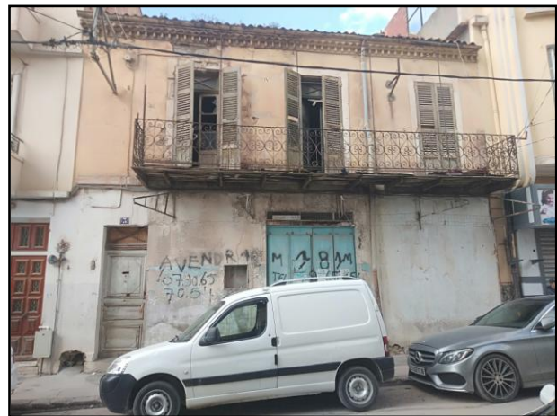
Photo IV.10. Locaux fermés dans une "Harat" vendue ,en attente de démolition
