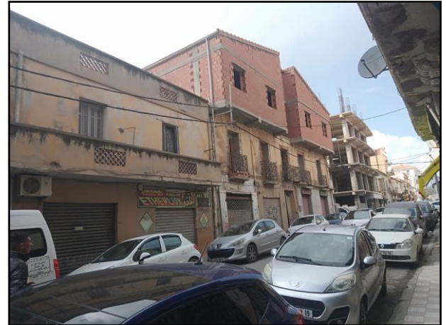
Photo IV.7. Locaux fermés dans une "Harat" en rénovation .
