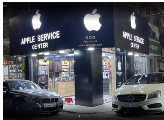
Photo IV.15. Local commercial totalement réaménagé, rue Amirouche (Exe rue Valée) Source : https://apple-service-centre-setif.business.site/2022
