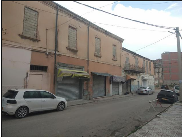
Photo IV.6. Locaux fermés dans une "Harat" menacée de ruine .
