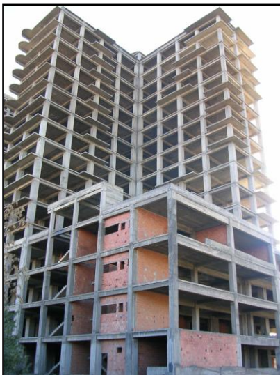
Photo IV.2. Structure du projet El-Ali de Sétif.(Actuel Park Mall) Source : l'auteur ,02/01/2006
