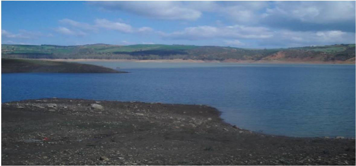
Fig17 :Barrage de Bohemdan le côté sud (station 1) (2014)
