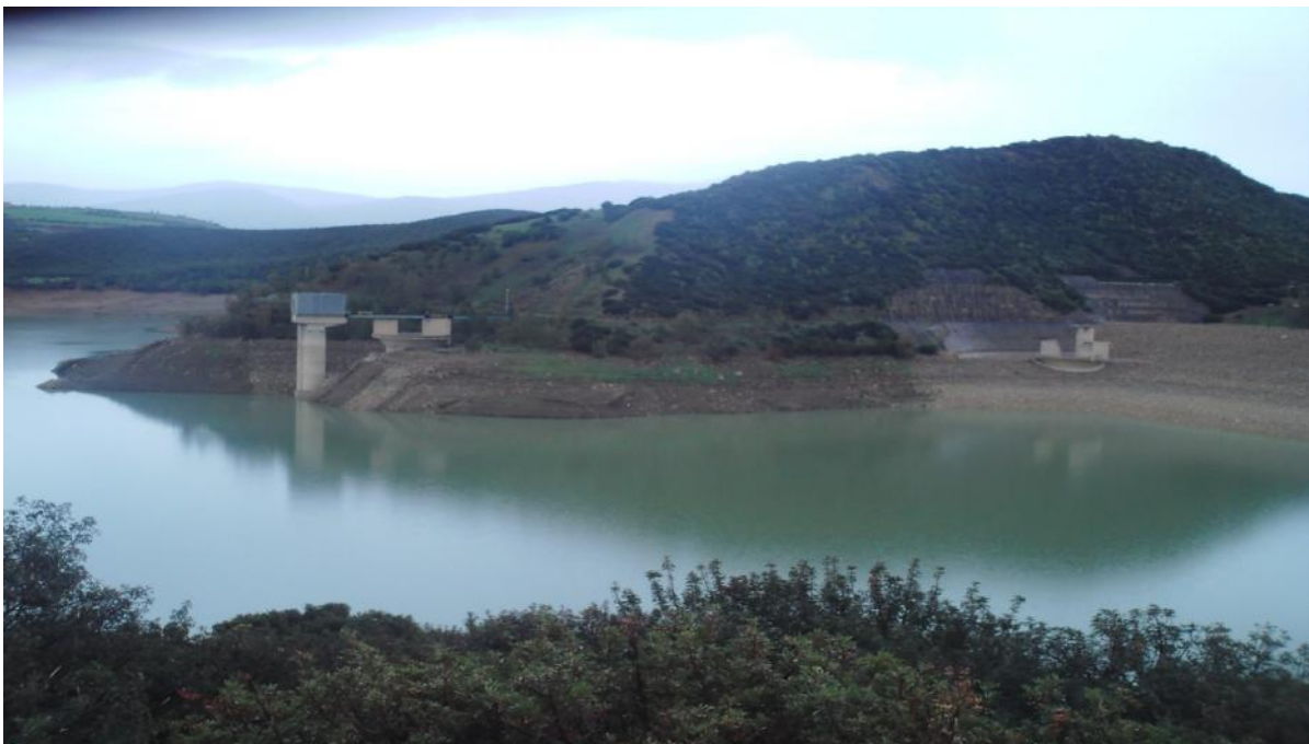
Fig18:Barrage de Bohemdan le côté nord(station 2) (2014)
