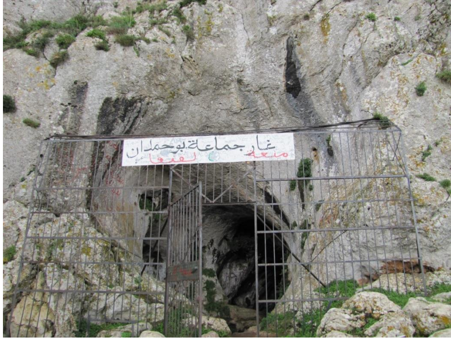
الصورة رقم 24: تشوّه مرئي لواجهة المغارة
