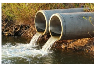
Figure I.1 : Déversements d'eaux usées
