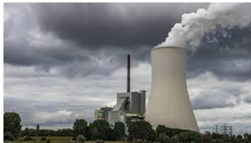
Figure I.7 : L'eau chaude des tours de refroidissement (pollution thermique)
