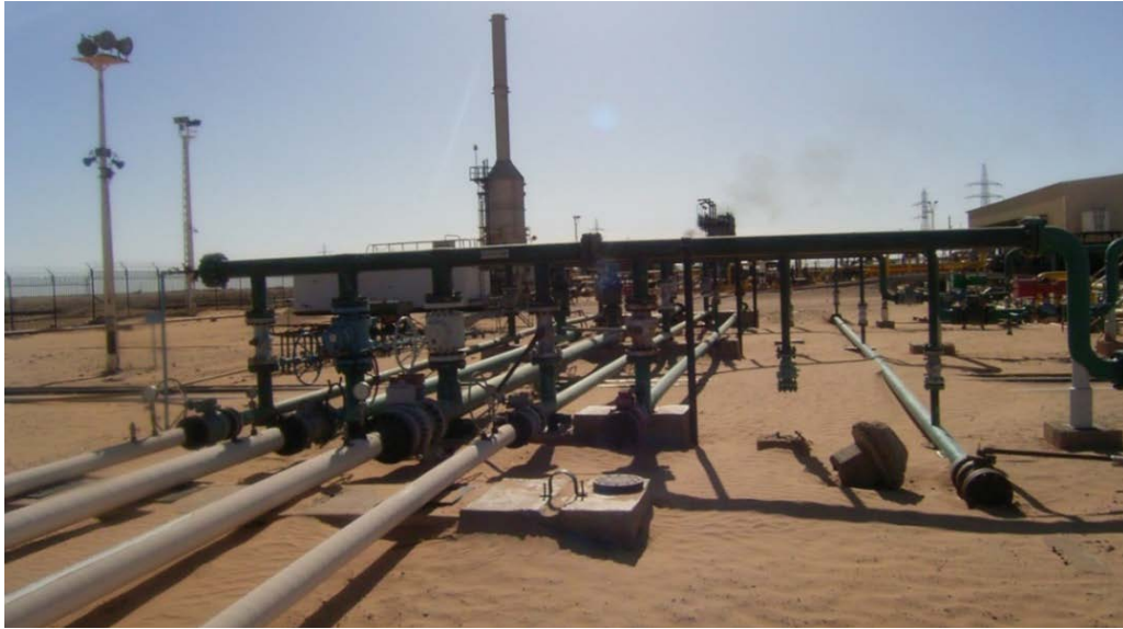
Figure III.5 : Collecteur (manifold).
