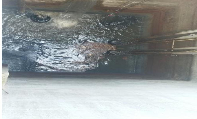
Figure 10 : Bassin de dégraissage
