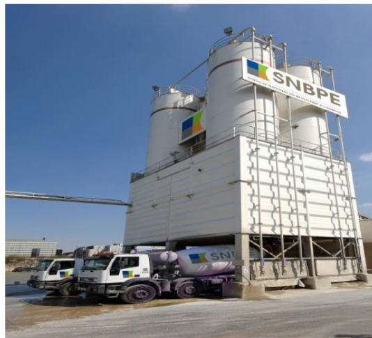
Figure I.2 : Centrale à béton prêt à l'emploi
