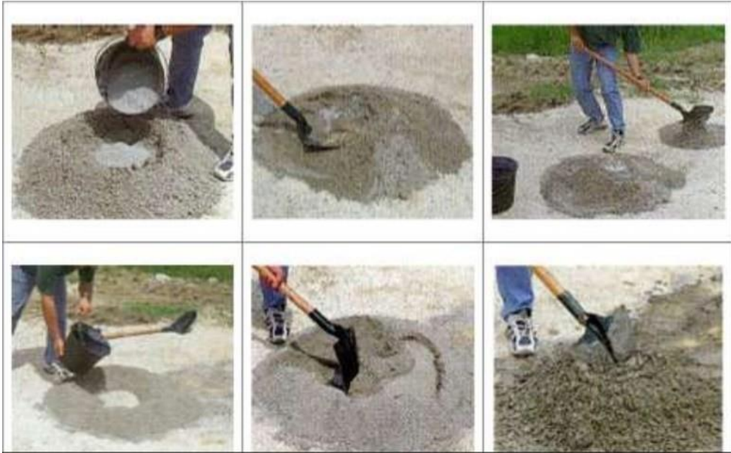
Figure I.3. Exemple d'une fabrication des mortiers à la main [5].
