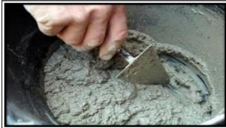
Figure I.1. Exemple d'un gâchait de mortier.[3].
