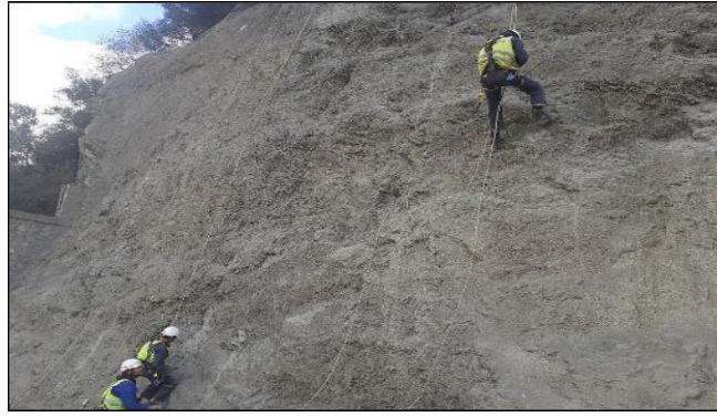
Figure. III.6 Travaux de pose de grillage
