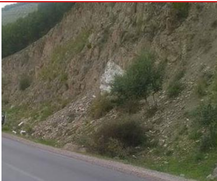
Figure IV.5 Eboulis de pente et des roches broyées et altérées.
