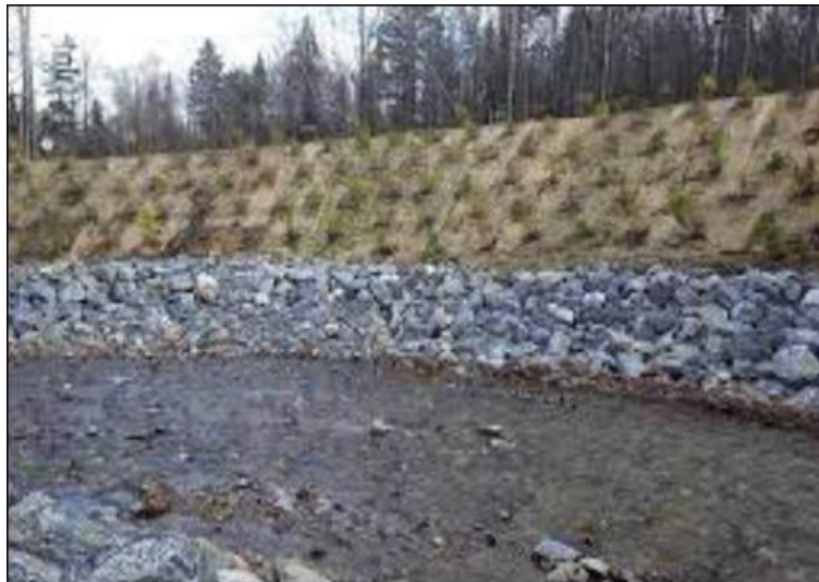
Figure .III.17 L'aplatissement des talus
