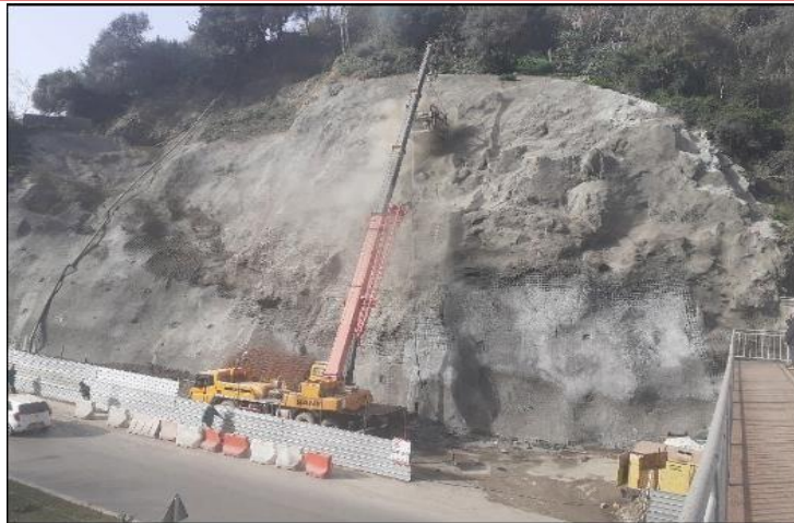
Figure.III.4 Travaux de réalisation de béton projeté
