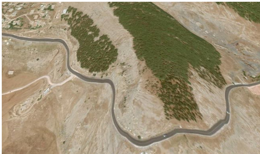
Figure.IV.2 localisation de pointe instable par rapport Au l'axe routier de la RN80
