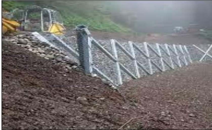
Figure .III.16 Les micropieux
