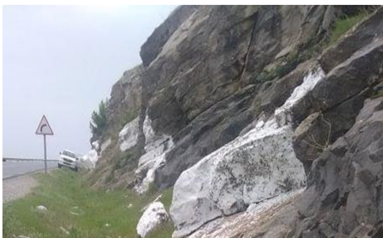
Figure IV.6 Calcaires marneux grisâtre fracturés.
