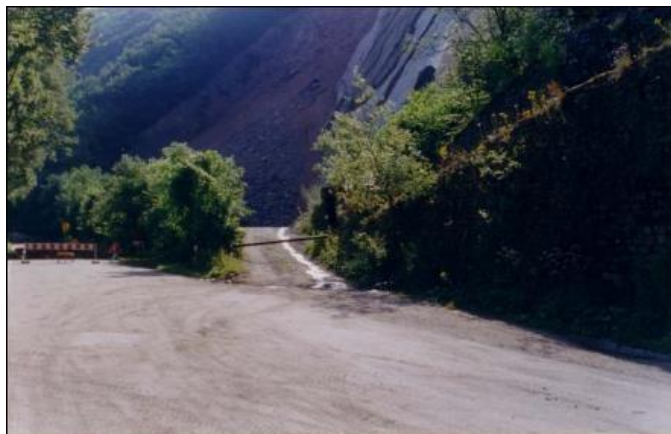
Figure .III.8 Eboulement à droite de route
