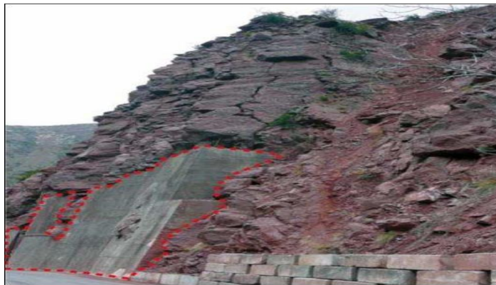
Figure. III.7 Travaux de soutènement
