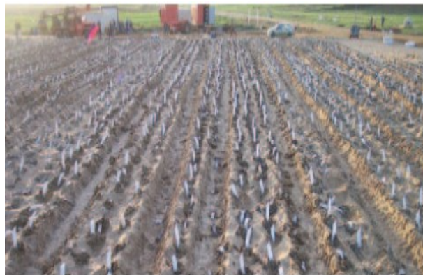
Figure I. 6. Chantier de réalisation des drains verticaux.
