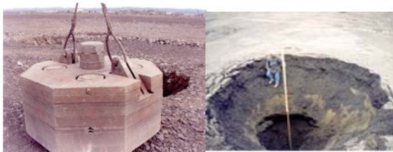
Figure I. 8. Le compactage dynamique.
