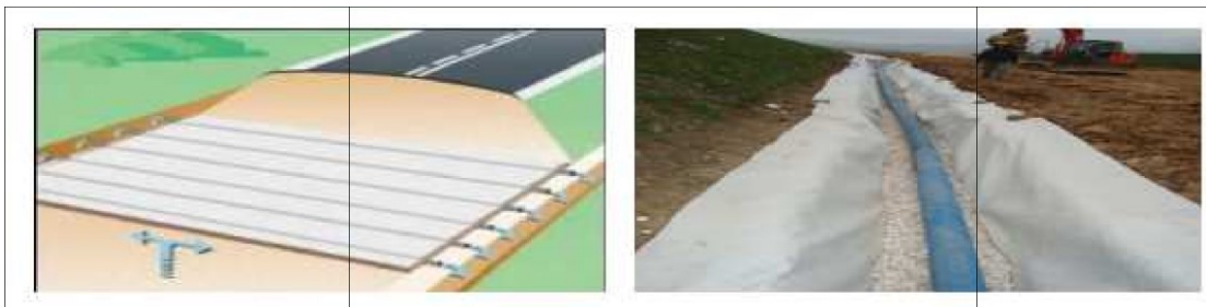
Figure I. 24. L'utilisation des géotextiles pour le drainage.
