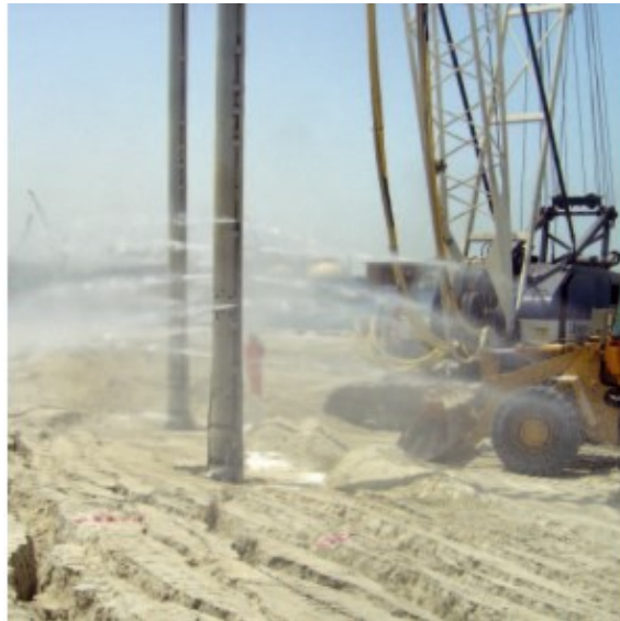
Figure I. 17. Chantier de réalisation des drains verticaux.
