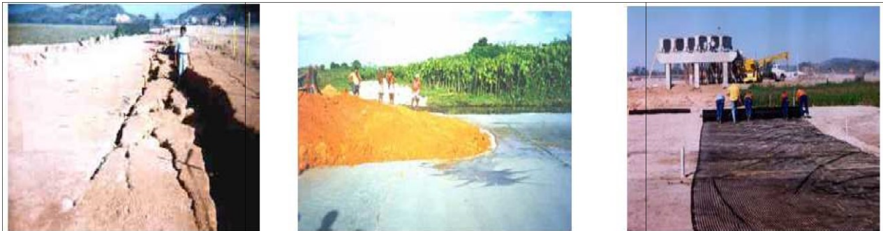
Figure I. 26. Rupture type d'un remblai non renforcé et utilisation de nappes géosynthétiques en renforcement.
