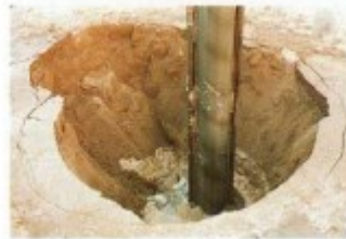
Figure I. 11. Le cône d'affaissement autour du vibreur.
