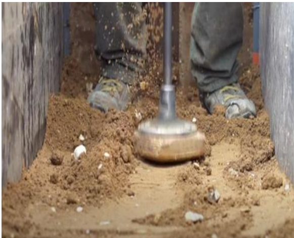
Fig 2.7 Compactage des couches de terre crue à l'aide d'un pilon
