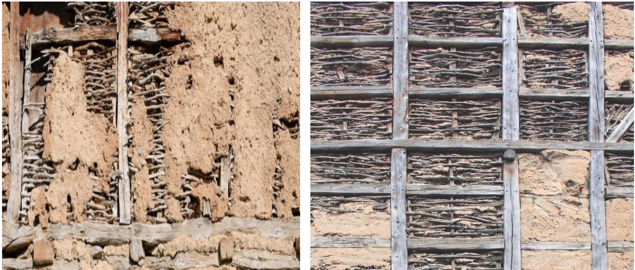
Fig 1.19 mur en torchis
