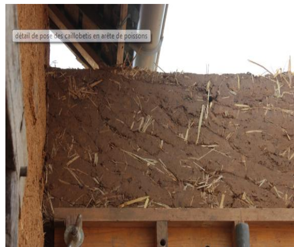
Fig 2.6 Amélioration à la fissuration
