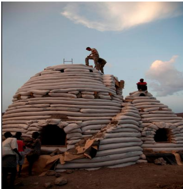
Fig 1.14 Construction en Superadobe
