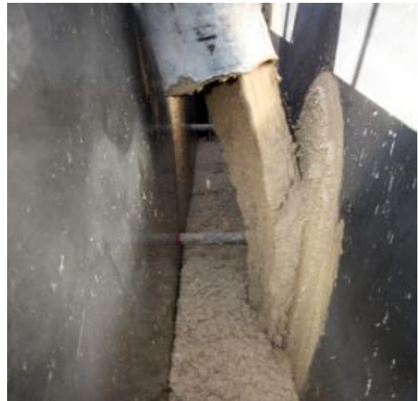
Fig 1.13 Travaux de coulage de la terre
