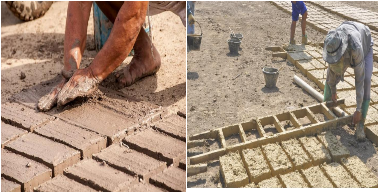
Fig 1.16 Façonnage de la Adobe
