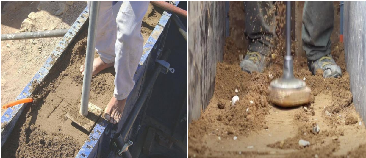
Fig 1.18 Compactage des couches de terre crue à l'aide d'un pilon
