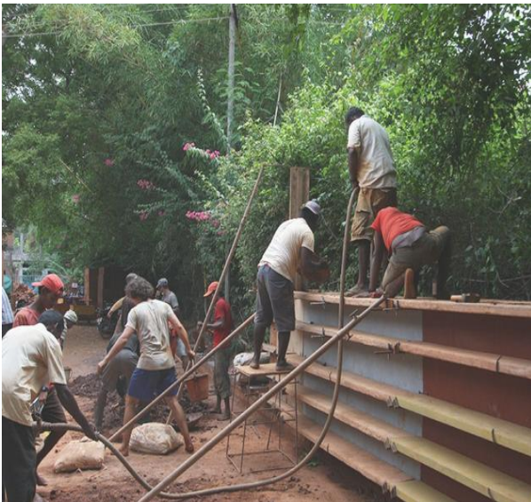
Fig 1.13 Travaux de coulage de la terre
