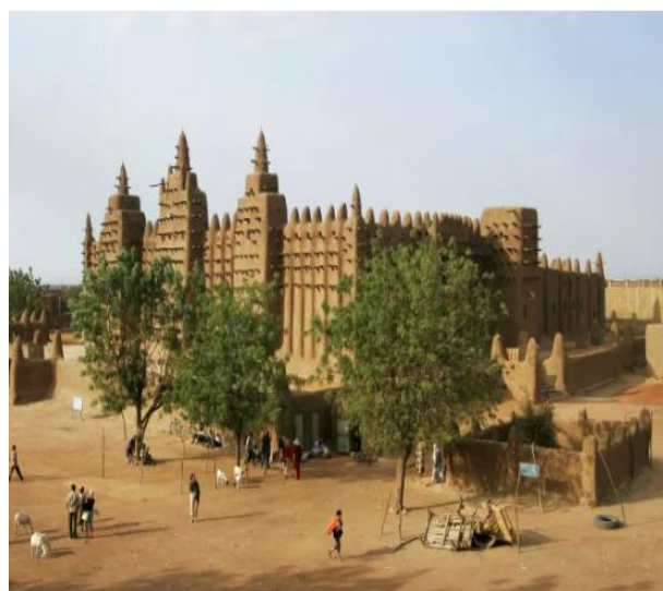
Fig 1.7 Grande Mosquée de Djenné au Mali
