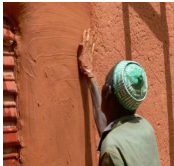
Fig 1.21 Contrôle du retrait
