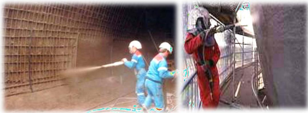
**Figure II.16 :** Renforcement au moyen de béton projeté.
