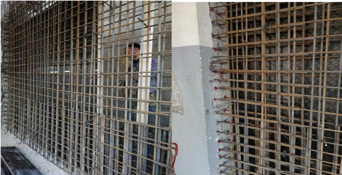
FigureII.6: Renforcement en béton armé par voiles de contreventement
