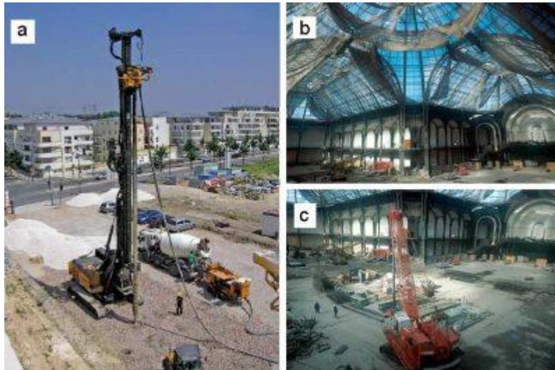
**Figure II.36** Renforcement des sols par ajout d'inclusion
