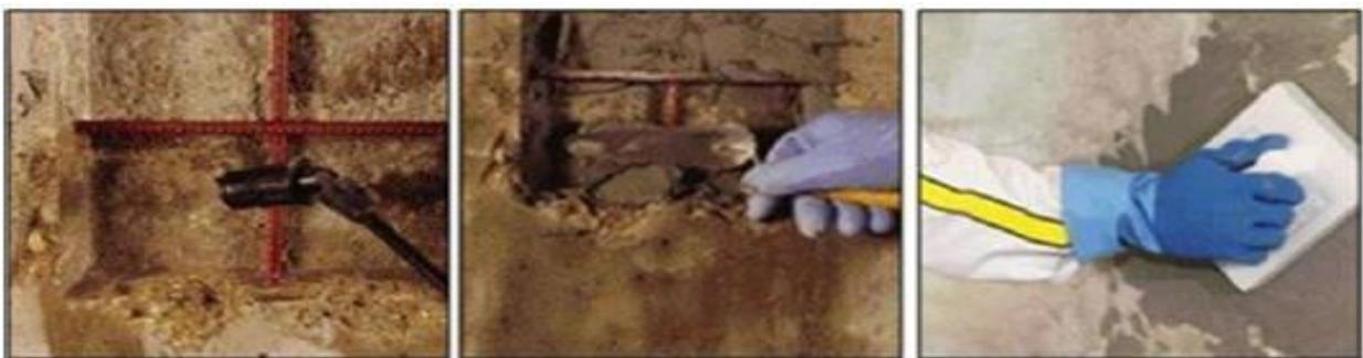
**Figure I.6 :** Aciers dégagés, Application du mortier et finissage par taloche. [10]
