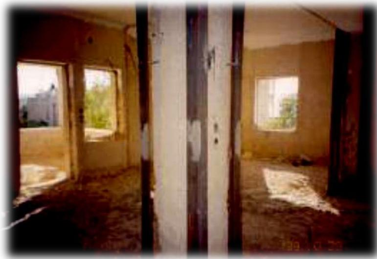
**FigureII.12** : Renforcement de poteaux au moyen de profilés métallique.
