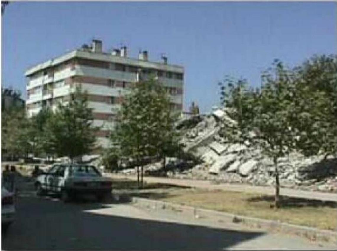
**Figure II.1 :** Comportement de deux immeubles voisins face aux secousses sismiques (Zacek,2008)
