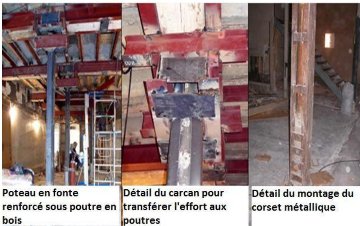
**Figure II.13 :** Des poteaux renforcés avec un corset en acier.
