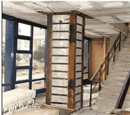
**Figure II.9 :** Chemisage d'un poteau en acier
