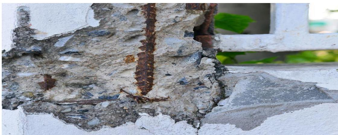
**Figure1.1 :** Pathologie de béton.
