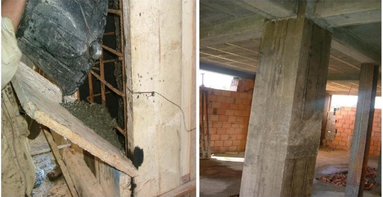
*Figure II.28:* Coffrage à mi-hauteur et résultat après décoffrage
