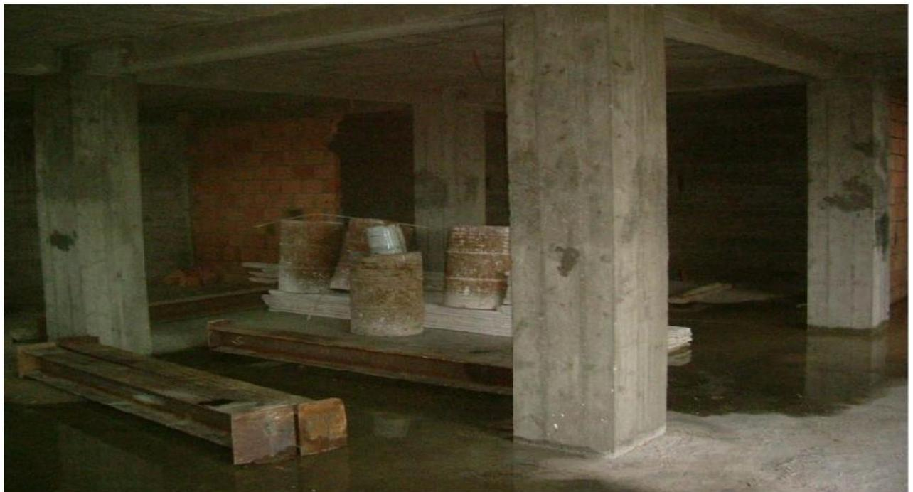
*Figure II.29 :* Chemisage des 4 poteaux sous-sol terminés
