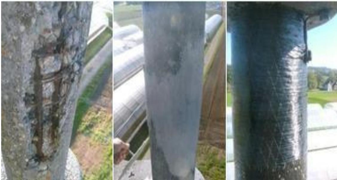
**Figure I.9 :** Tissus de fibre de carbone. [6]
