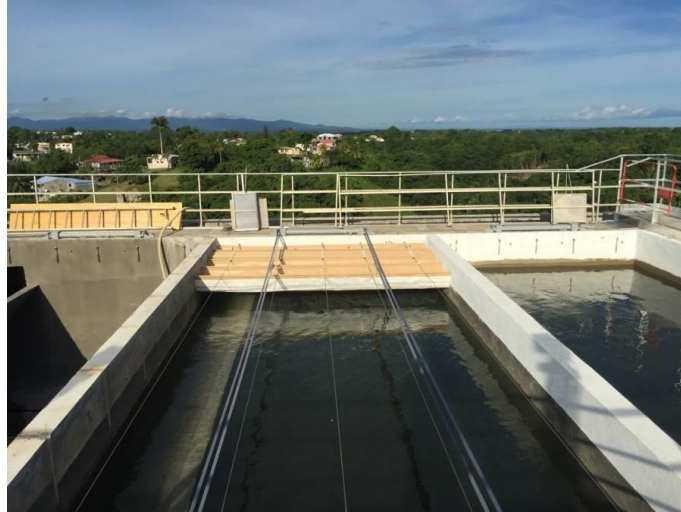
Figure 13 : Bassin de filtration.
