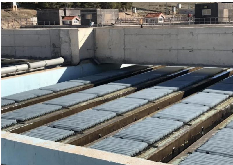
Figure 29 : Décanteur lamellaire de la station El Maouane.
