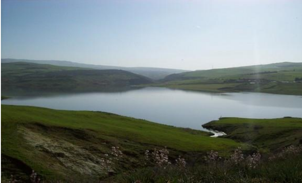
Figure 24 : Barrage El Maouane Sétif.
