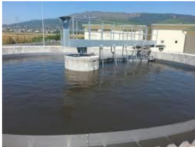
Figure 10 : Bassin de décantation.
