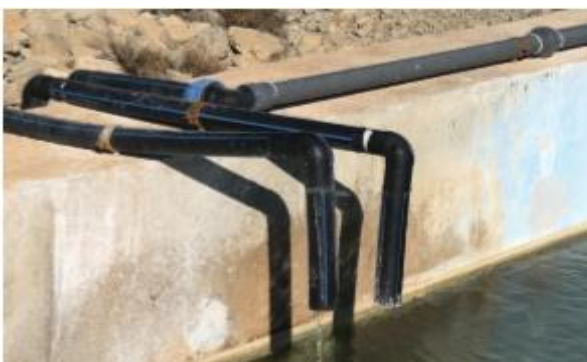
Figure 27 : Coagulateur de la station El Maouane.
