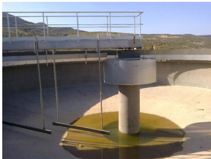
Figure 12 : Décanteur à flux vertical.
