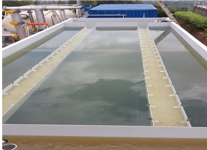
Figure 11 : Décanteur à flux horizontal.
