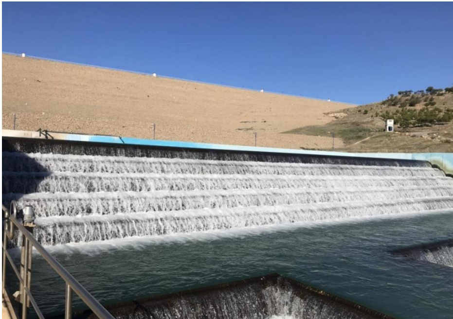
Figure 25 : Cascade d'aération du barrage de la station El Maouane.
