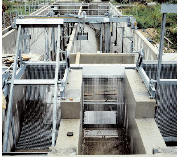
Figure 2 : Dégrilleur.
