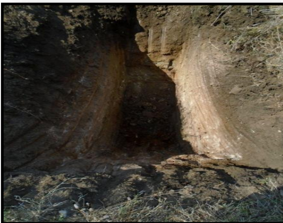
Puits N° 02 (PK 17+500)
