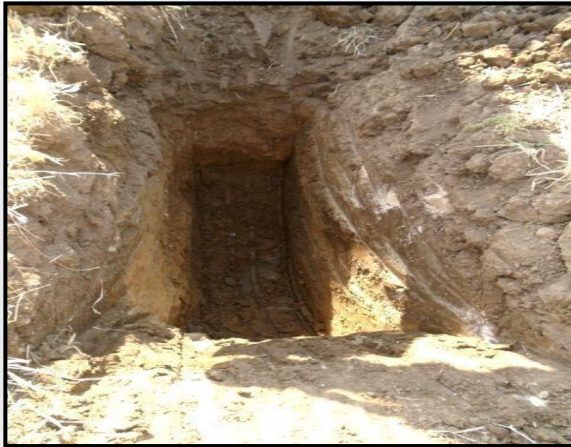
Puits N° 01 (PK 14+200)
