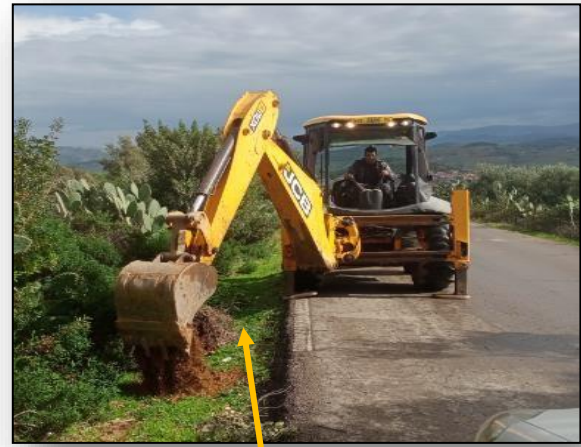
Exécution des puits
