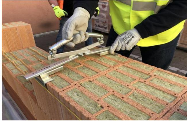
Figure I.15 : brique mono mur.
