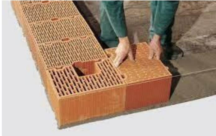
**Figure I.12 :** brique alvéolaire.
