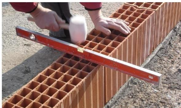
Figure I.11 : brique creuse classique.
