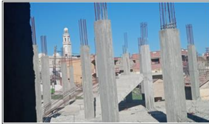
Figure II.1 : poteaux d'un immeuble en cours de construction dans la commune de Tamlouka [2].
