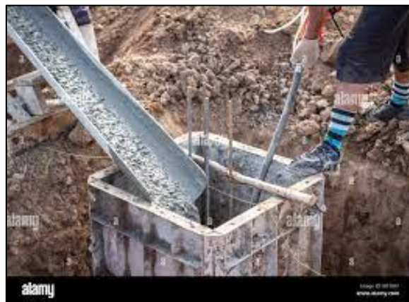
Figure II.4. Coulage d'un poteau [4].
