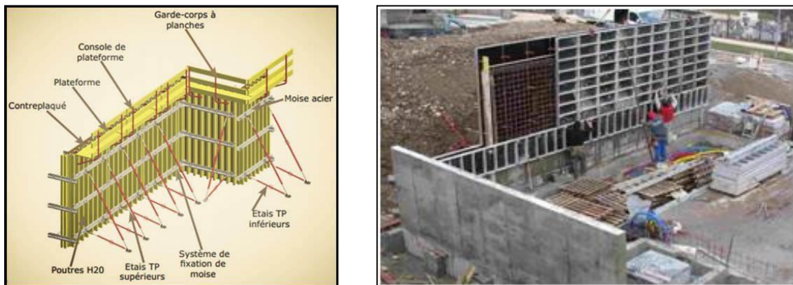
Figure II.22. Coffrage d'un voile en béton armé [16].
