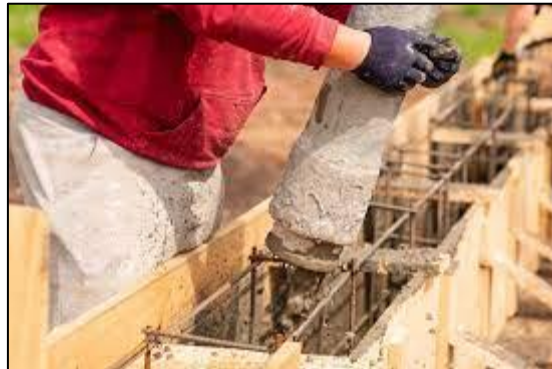
Figure II-16. Coulage d'une poutre en béton armé.
