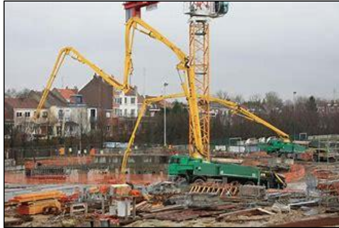
Figure II.23. Coulage d'un voile en béton armé.
