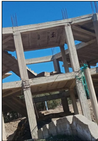
Figure II.7 : Croisement des poteaux et des poutres.
