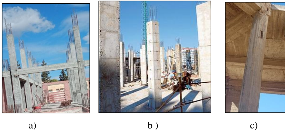
Figure II.2. Formes courantes des poteaux : a) rectangle, b) carré, c) cercle.
