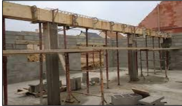
Figure II-10. Coffrage d'une poutre rectangulaire en béton armé.
