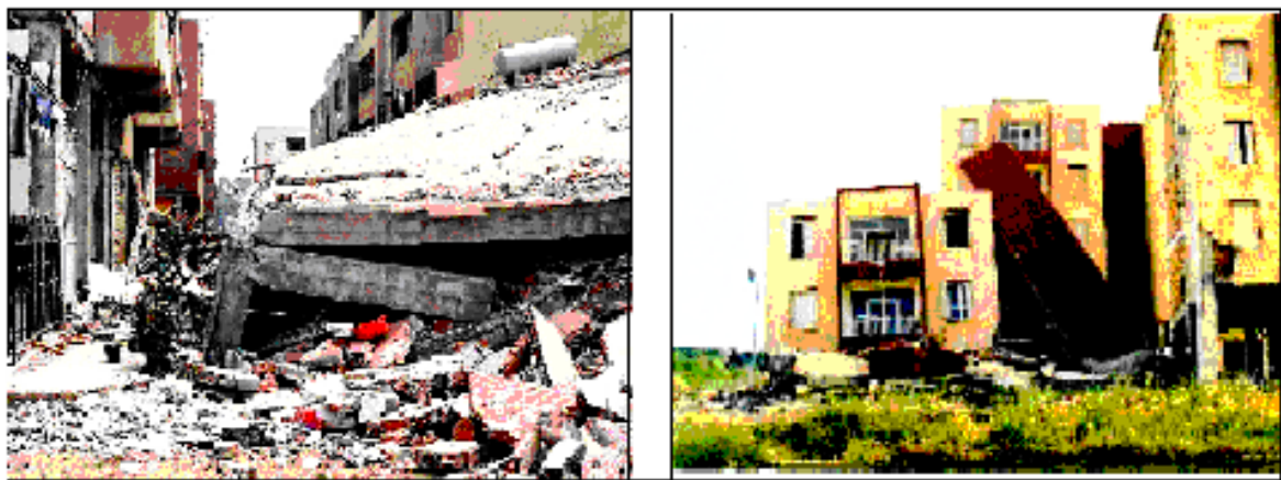
Figure I.6 : Exemples de dégâts occasionnés par le séisme de Boumerdes (2003).
