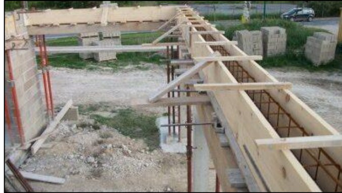
Figure II-15. Coffrage d'une poutre en béton armé.
