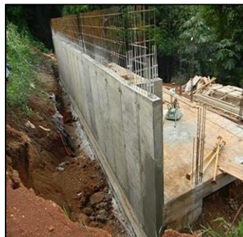
Figure II.21. Voile en béton armé en cours de réalisation dans la commune de Tamlouka [2].
