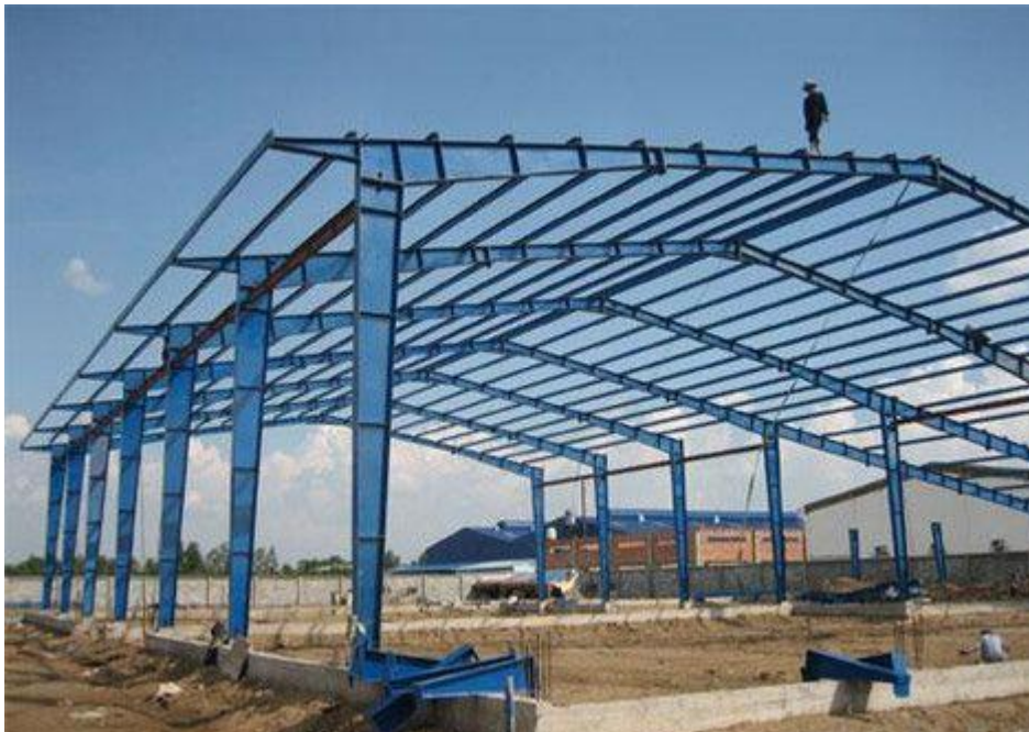
Figure 6 : Structures en portiques.
