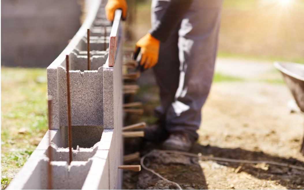
Figure 4 : Murs en maçonnerie.
