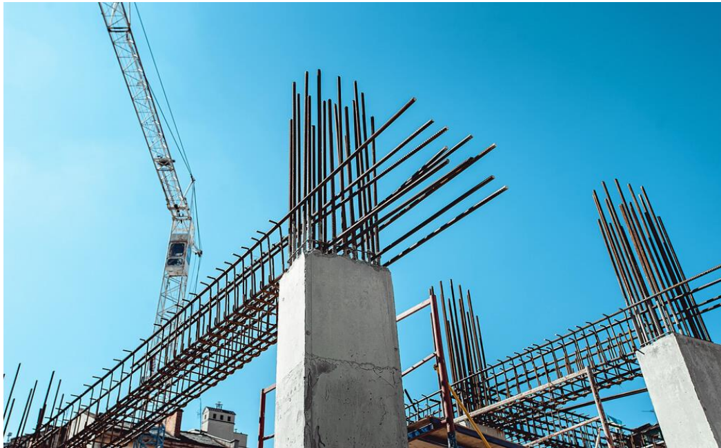
Figure 1: Structure en Béton Armé.
