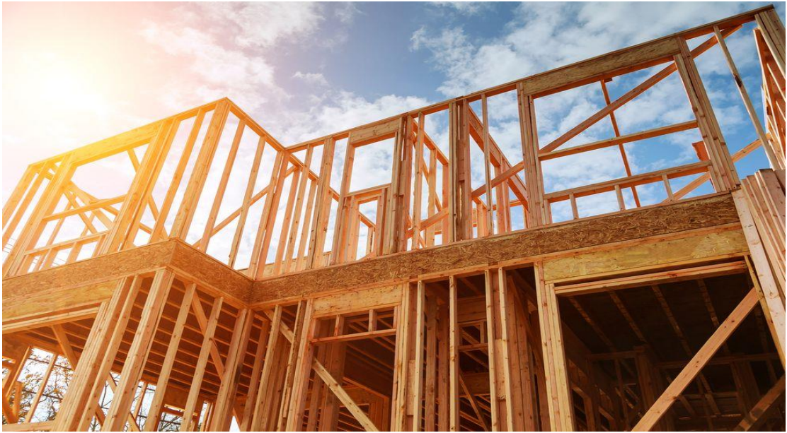
Figure 3 : Structure en Bois.
