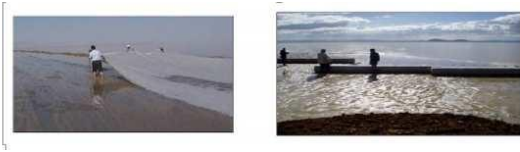
Figure II.14. Pose des géogrilles de séparation
