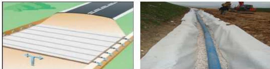
Figure II.21. L'utilisation des géotextiles pour le drainage.
