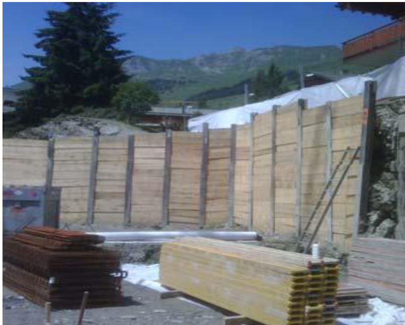
Figure I.9. Murs de soutènement en paroi berlinoise
