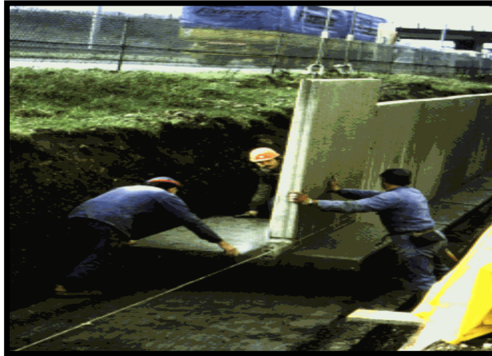
Figure I.5. Murs cantilever en béton armée
