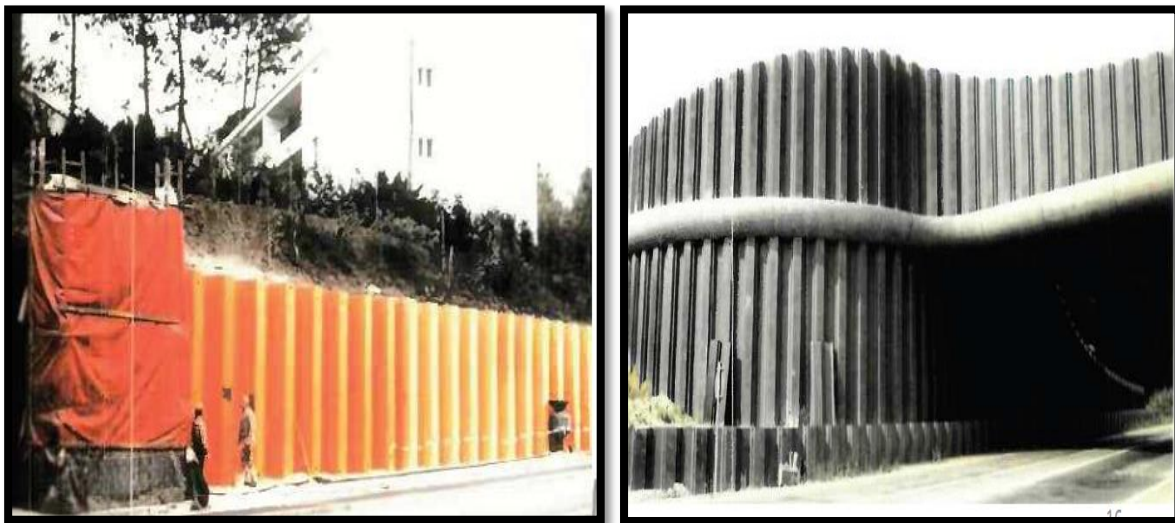
Figure I.8. Murs de soutènements en palplanche métallique
