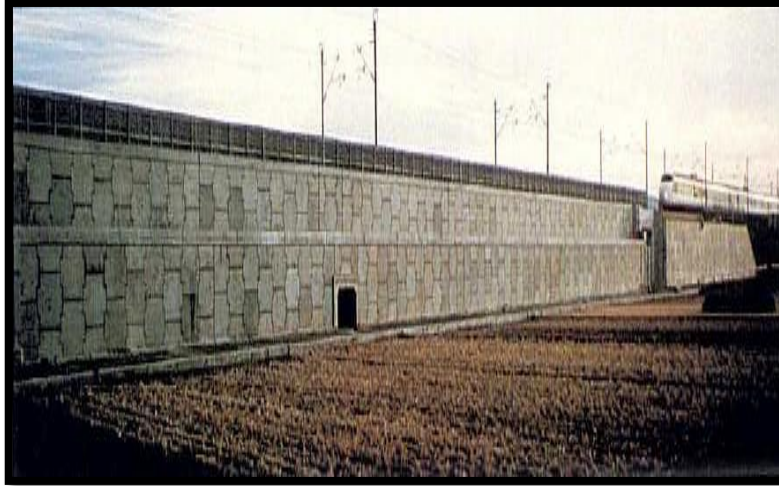
Figure I. 3. Mur de soutènement en terre armée
