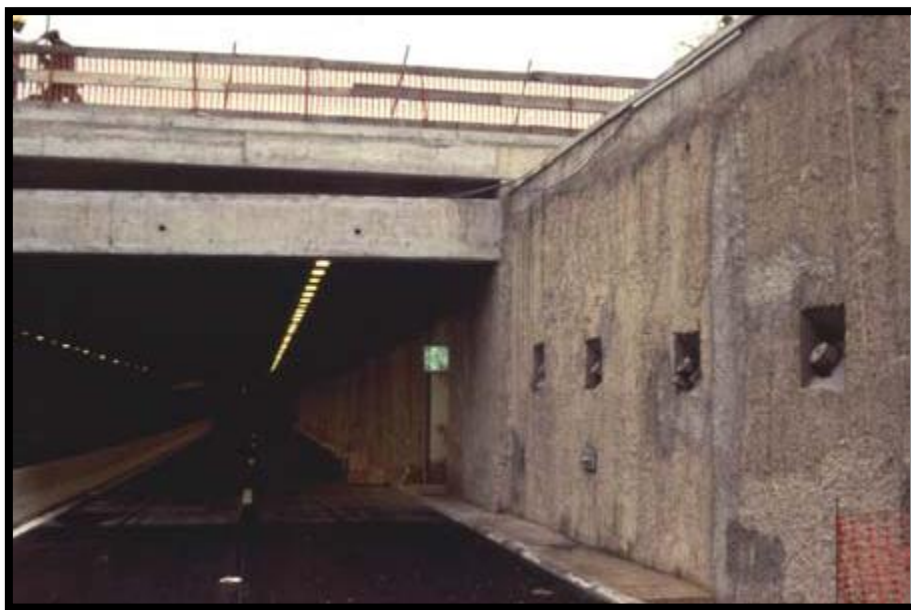
Figure I.7. Mur en parois moulées
