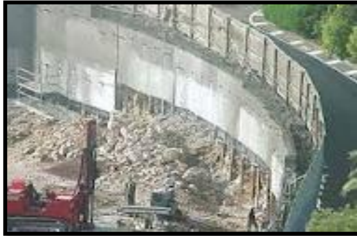
Figure I.11. Mur de soutènement en paroi parisiennes
