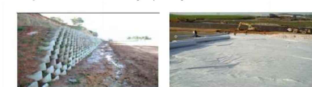
Figure II.16. Pose des géotextiles de renforcement
