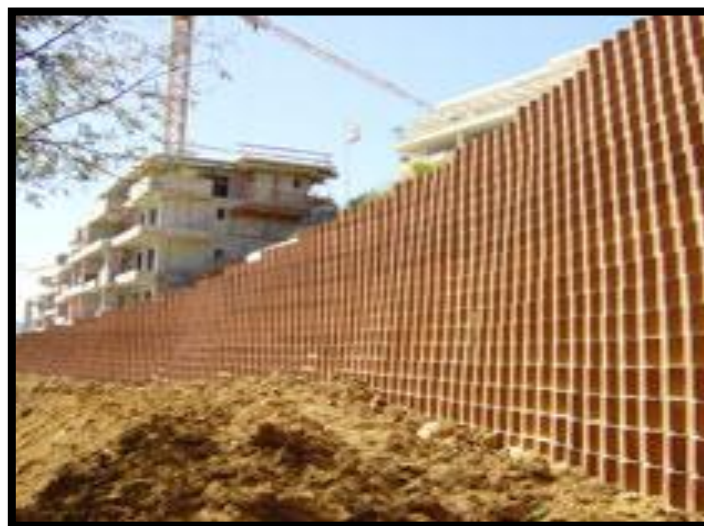
Figure I.4. Mur de soutènement cellulaire
