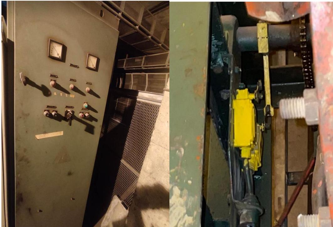
Figure II. 17 Les conditions de la résistance liquide (Rhéostat en max et fin de courses en position haut).
