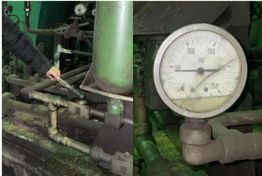
**Figure II. 19** La vanne manuelle de l'accumulateur et le baromètre.
