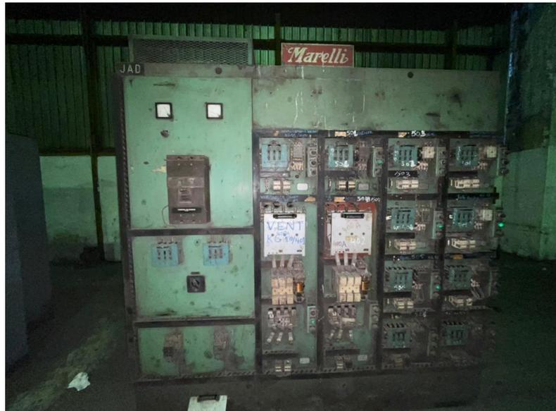
Figure II. 13 Armoire de contrôle de ventilation.
