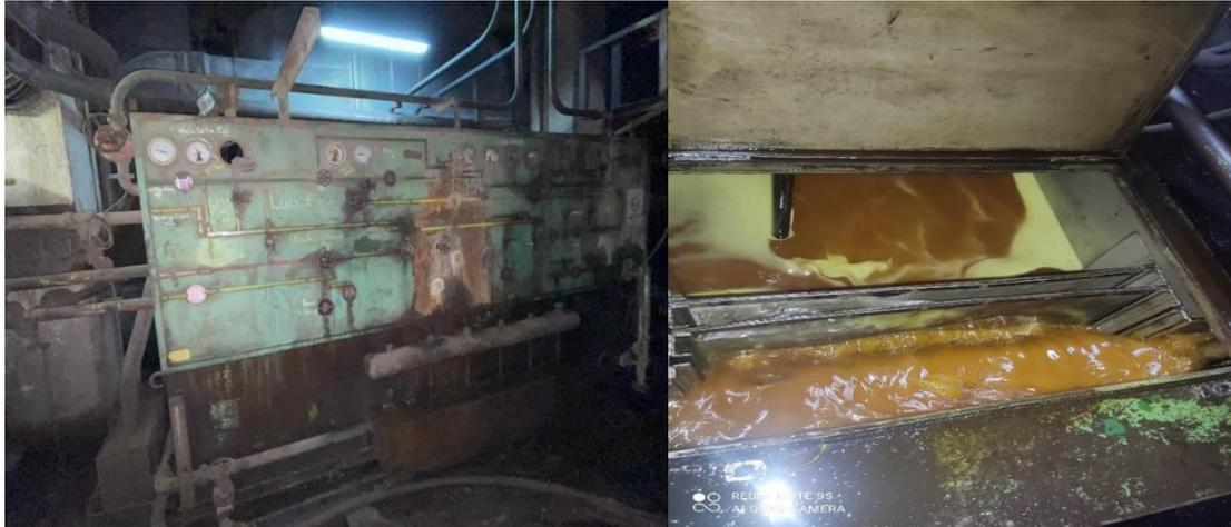
Figure II. 15 Réservoir de produit de lubrification.
