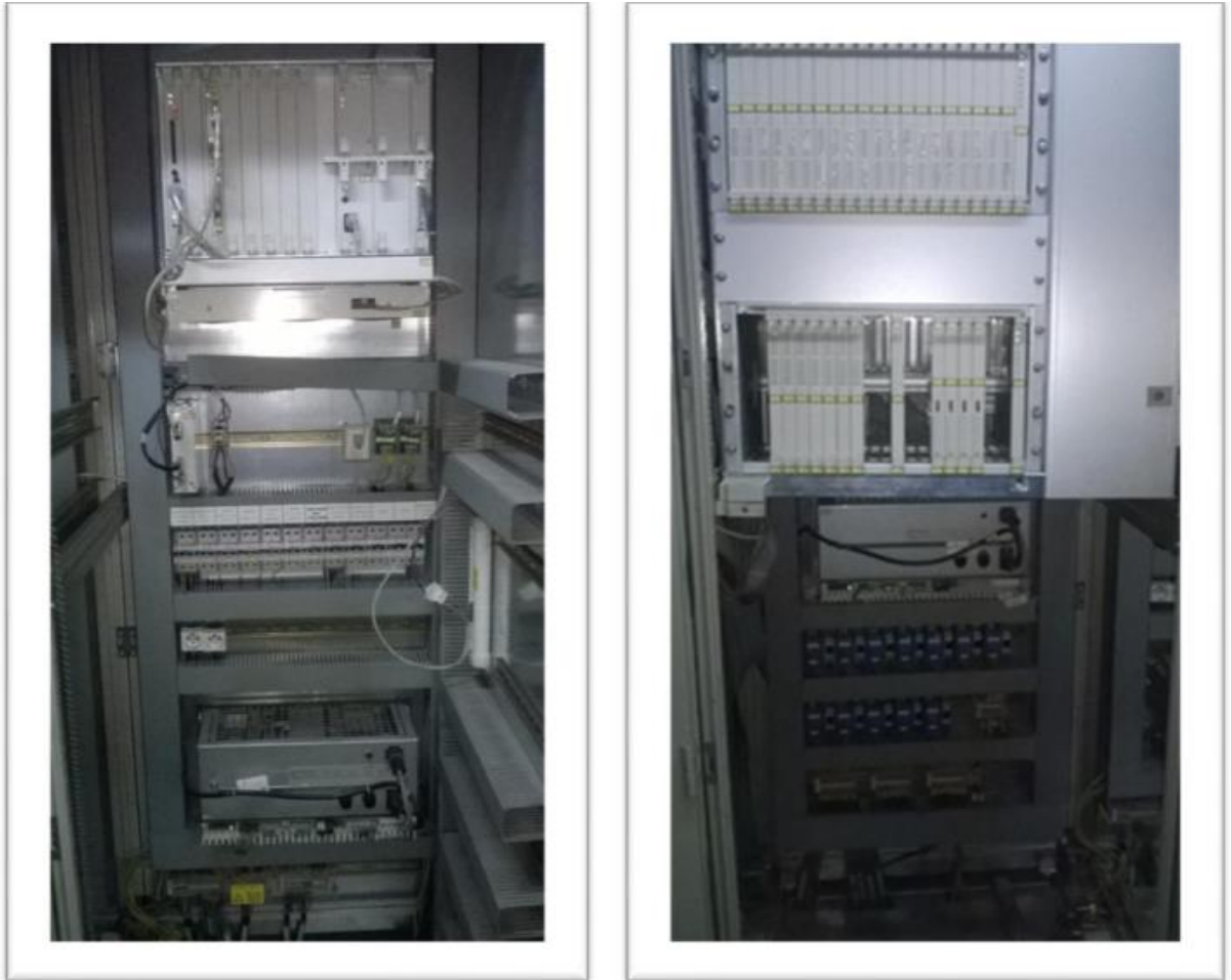
Figure III.8 : Armoire de l'AC450.
