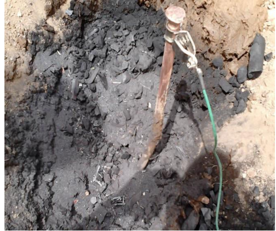
Figure. I.4 : Ajout de l'eau de la Mer Morte avec du charbon et de la limaille de fer dans le trou du système de mise à la terre [2].
