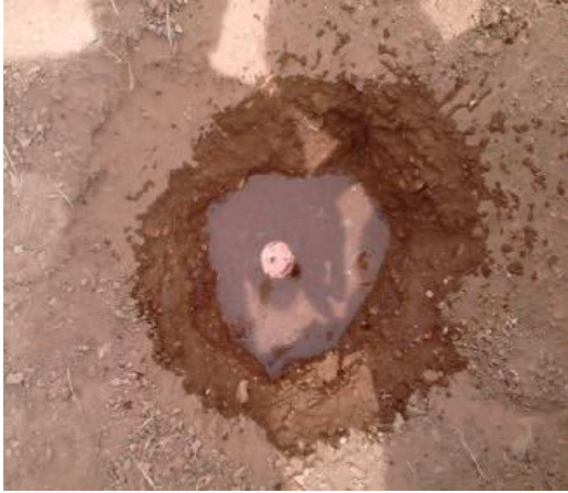
Figure. I.3 : Ajout de l'eau de la mer morte au trou du système de mise à la terre [2].
