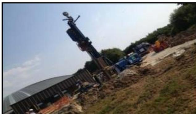
**Figure 72 : l'installation d'une pompe à chaleur réversible eau-eau par capteur pour la géothermie.**Source : [www.autisme13.fr](http://www.autisme13.fr)
