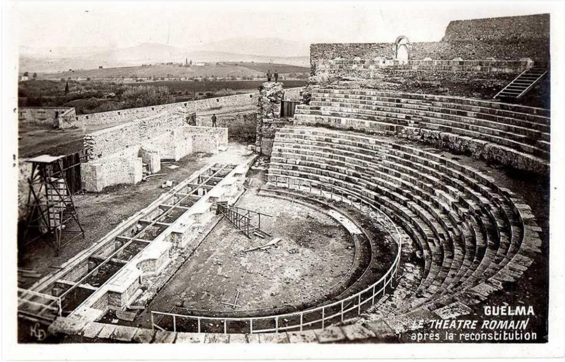
صورة رقم 28: مسرح كالما أثناء الترميم
