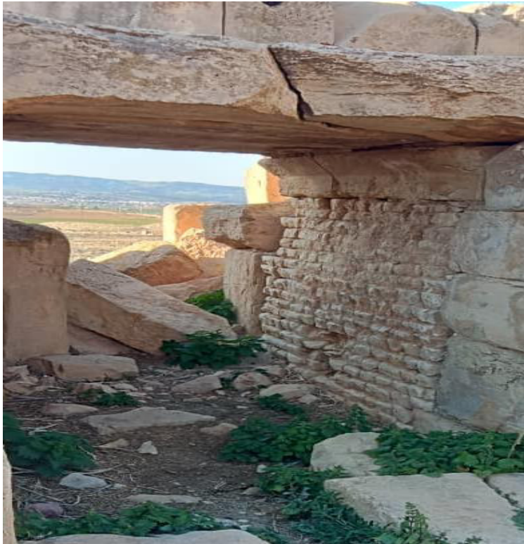
صورة رقم 27: تقنية البناء بالحجارة الصغيرة (تصوير الطالب)
