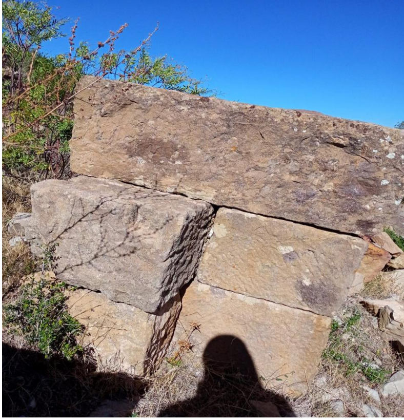
الصورة رقم 27: صورة لتقنية النظام الكبير لمنزل ليفيوس
