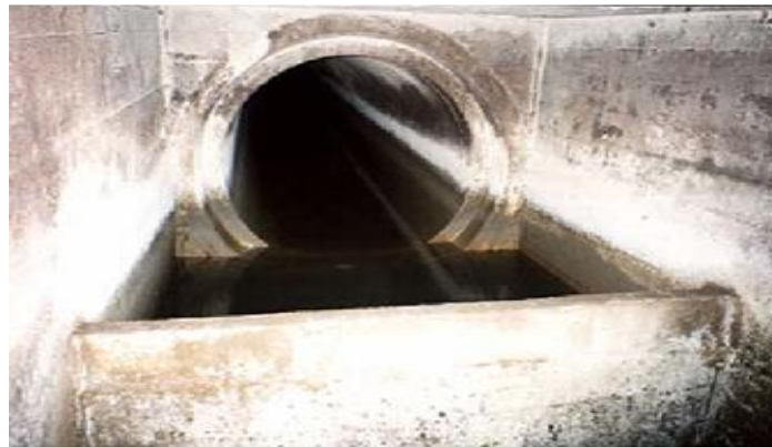
Figure 5.12. Déversoir à seuil frontal.
