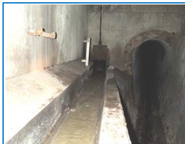
Figure 5.13. Déversoir classique à seuil latéral biais.
