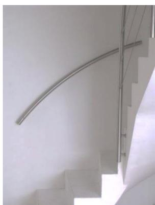
**Figure 19 : Main courante fixé au mur**
