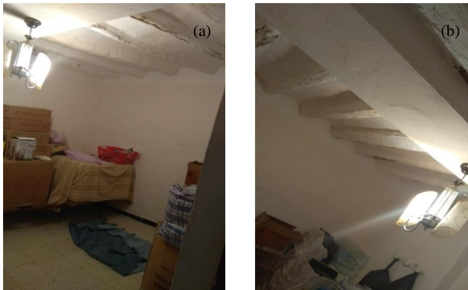
Figure IV.29 : (a), (b) Photos de plancher de troncs de palmiers et voûtains dans la chambre de l'étage dans le premier cas d'étude (Auteur, 2018)
