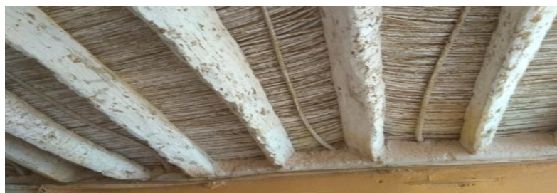
Figure II.30 : Plancher d'un passage couvert en roseaux dans le Ksar d'Al Atteuf (A, 2018)
