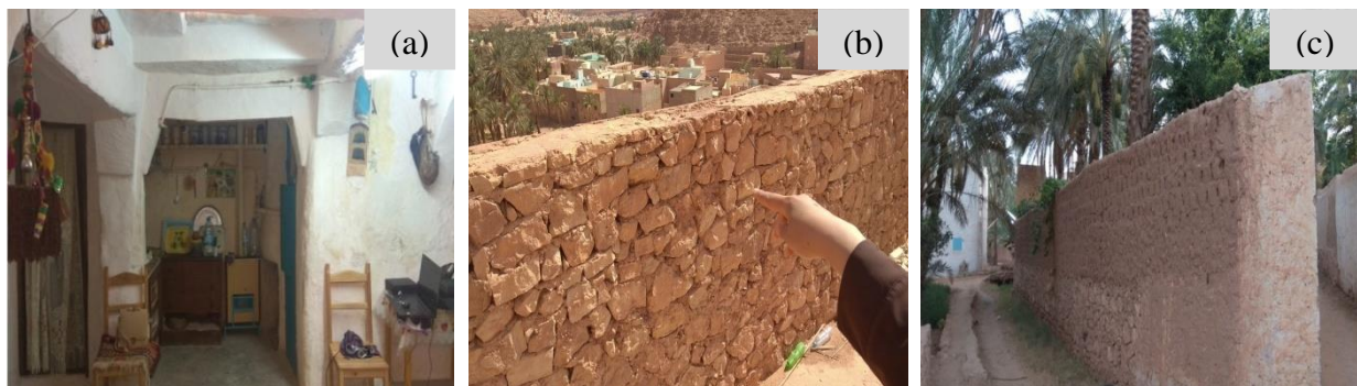
Figure I.32 : Matériaux locaux dans la vallée du M'Zab : (a), (b) l'utilisation de la pierre dans les murs des maisons mozabites ; (c) mur en terre crue dans la palmeraie de Béni Isguen (Auteur, 2018)
