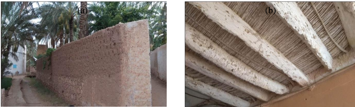
Figure IV.15 : (a) Mur en terre dans la maison de palmeraie de Béni Isguen ; (b) Toit en palmier (Auteur, 2018)
