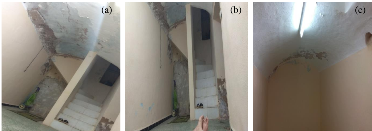
Figure II.39 : Forme de plancher sous-sol (la cave) en voûte d'une habitation dans le Ksar de Béni Isguen (cas d'étude traité) : (a), (b), (c) différente prise de vues (Auteur, 2018)
