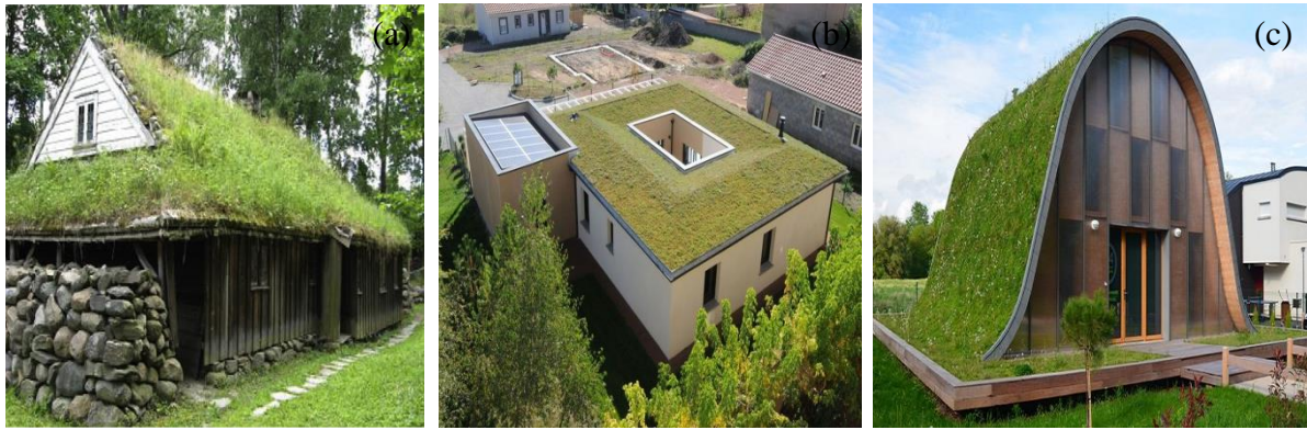
Figure II.12 : Bâtiments avec toiture végétale : (a) Toit vert traditionnel incliné avec végétation indigène en Norvège (Ayata, Tabares-Velasco, & Srebric, 2011) ; (b), (c) toit végétal plat et toit végétal arrondi respectivement (Google image, 2021)
