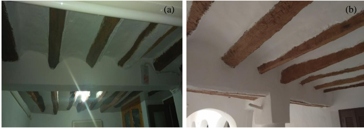
Figure IV.29 : (a), (b) Photos de plancher de troncs de palmiers et voûtains dans la chambre de l'étage dans le premier cas d'étude (Auteur, 2018)
