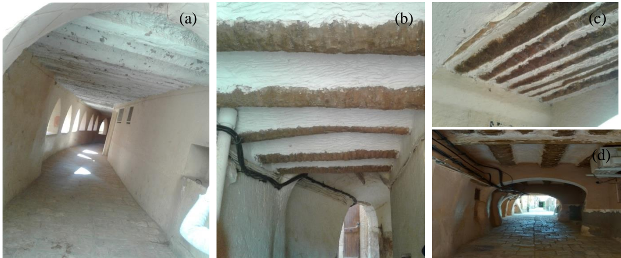
Figure II.33 : Plancher en troncs de palmiers et voûtains dans un passage couvert : (a), (b), (c), (d) planchers d'un passage couvert dans le Ksar de Béni Isguen (Auteur, 2018)
