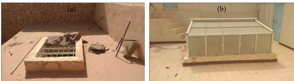
Figure IV.14 : (a) Vue de chebek depuis la terrasse ; (b) vue de couvert de chebek dans la terrasse d'une maison à béni Isguen (Auteur, 2018)
