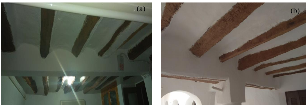
Figure II.32 : Photos montrant le toit en troncs de palmiers et voûtain dans un cas d'étude traité : (a) vue de l'intérieur du toit de la chambre de l'étage, (b) plancher de la galerie (Ikomar) autour du patio (Auteur, 2018)
