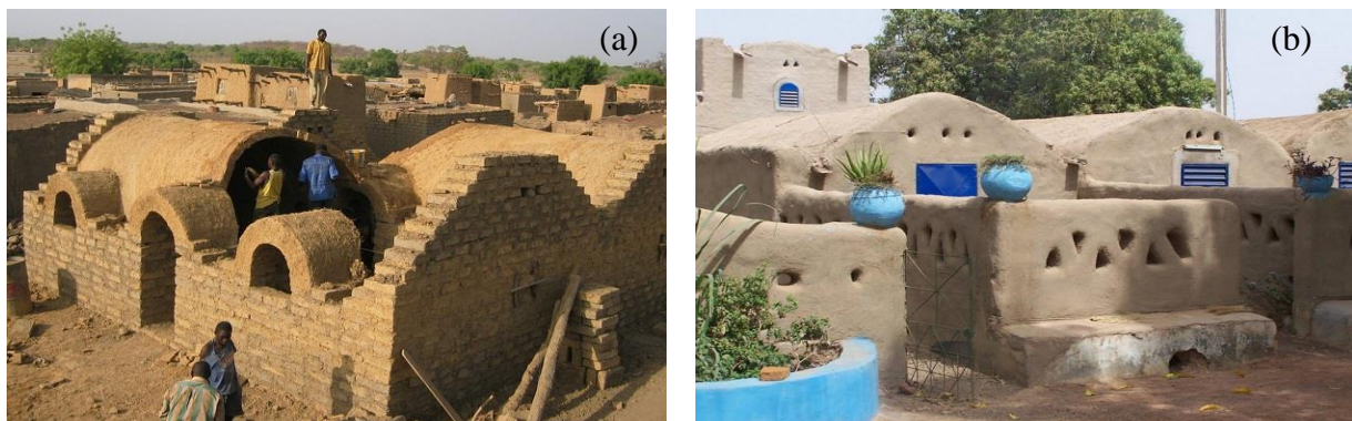
Figure II.23: Construction en voûte nubienne dans l'architecture sahélienne : (a) vue de construction en voûte nubienne au cours de la réalisation (Granier et al., 2006) ; (b) Vue extérieure d'une maison voûtée ( https://maison-monde.com/technique-voûte-nubienne/ )
