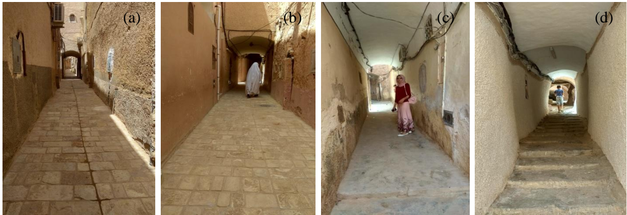
Figure II.38 : Utilisation des voûtes : (a), (b), (c), (d) utilisation des voûtes dans les passages couverts du Ksar de Béni Isguen (Auteur, 2018)
