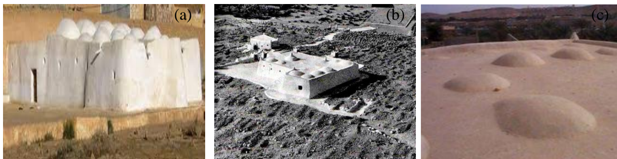
Figure II.37 : Photos des constructions en coupoles dans la vallée du M'Zab : (a) Mosquée Ba-Aissa Oualouane à Ghardaïa ; (b) Mausolé Chikh Baba-Ouljemma ; (c) Photos de coupoles aplatées du mosquée Agherme Ouaday- Mélika (OPVM, 2013)
