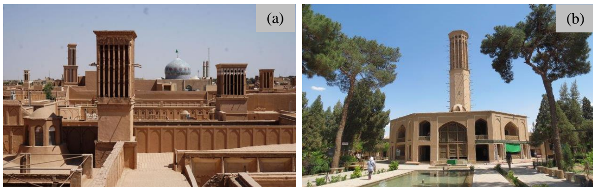
Figure I.25 : (a) tours à vent à Yazd ; (b) le capteur de vent dans le jardin de Dolat Abad, Yazd, Iran (Maleki, 2011)
