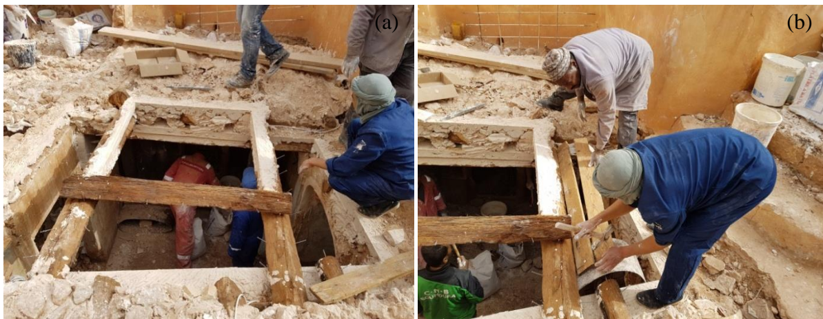
Figure II.34 : Photo montrant le coffrage d'un toit en troncs de palmier au cours de réalisation : (a) le coffrage de plancher en palmes ; (b) le coffrage de voûtain (Auteur, 2018)
