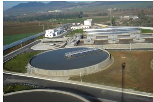
Bassin de clarification
