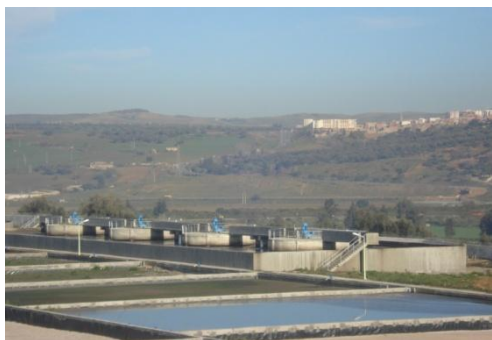
Bassin de désinfection
