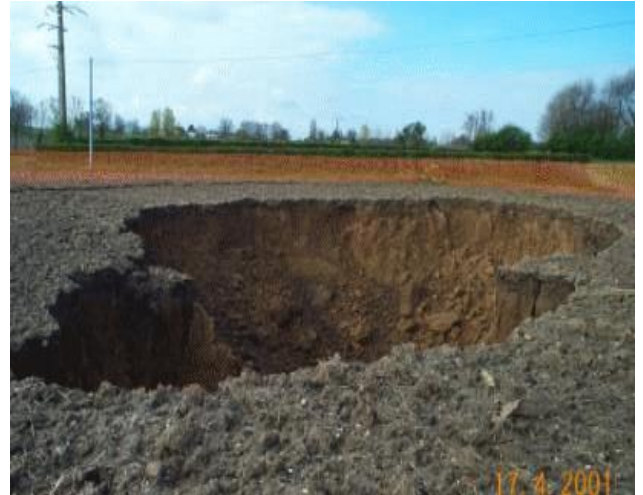
Figure I.7. Affaissement de terrain.
