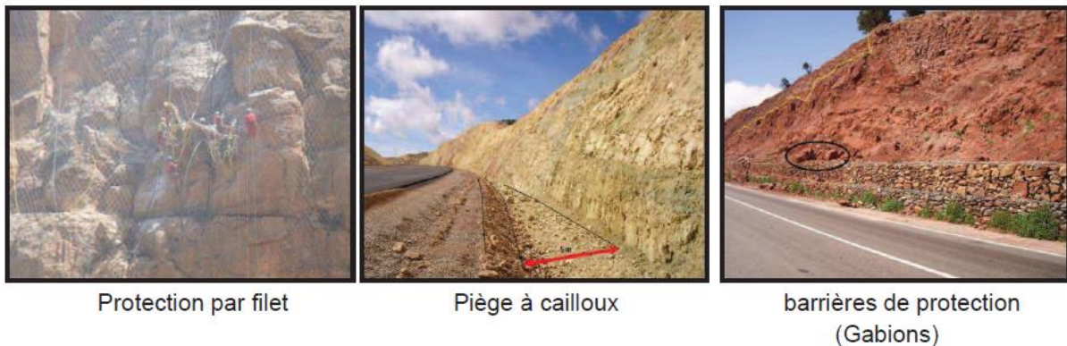
Figure IV.9. Techniques de stabilisation[56].
