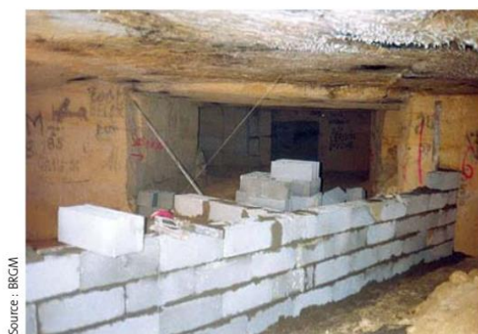
Figure IV.11. Injection d'un mélange de sable et d'eau ( facilitant le transport ) dans la cavité. Le mur en parainge à pour role de contenir le sable infecté dans la cavité tout en laissant circuler l'eau.
