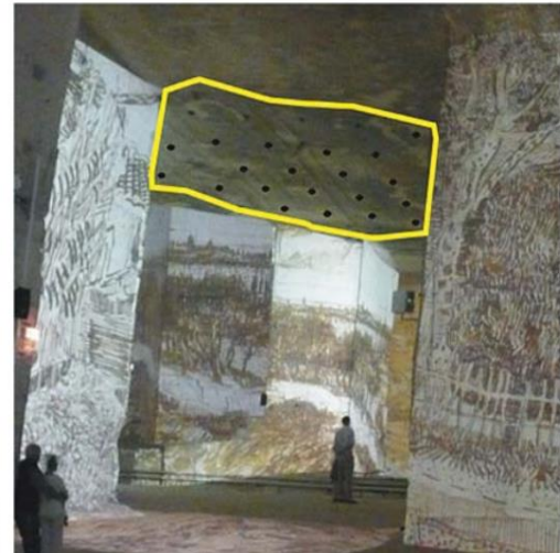
Figure IV.13. Boulonnage du toit .
