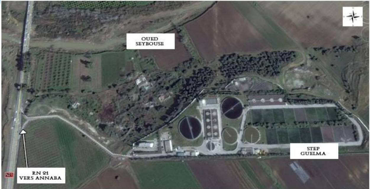
Figure 09 : Photo aérienne de la STEP Guelma (Google Earth, 2015).
