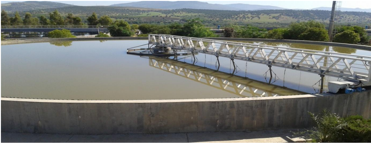
Figure 13: Décanteur primaire (STEP Guelma, 2015).
