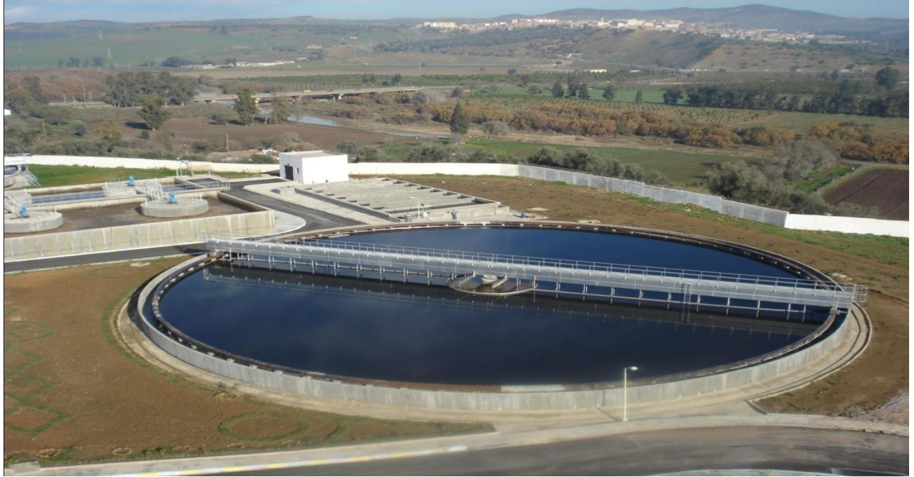
Figure 15 : Bassin de clarification (STEP Guelma, 2015).
