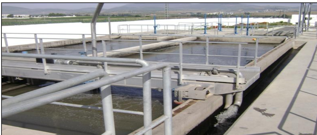
Figure 12 : Bassins de dessablage, déshuilage et dégraissage (STEP Guelma, 2015).
