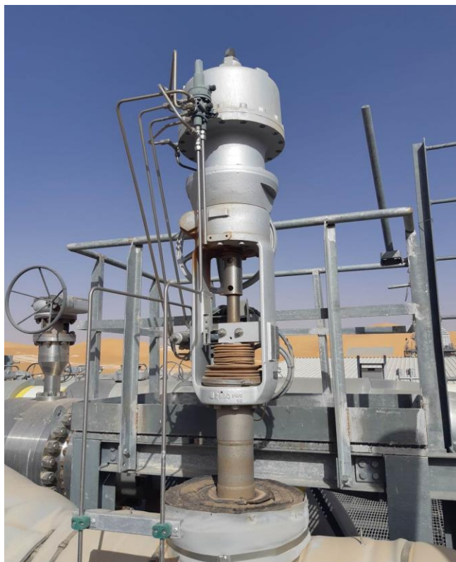
Figure II.5. Vanne Joule Thomson utilisé dans SH-FCP
