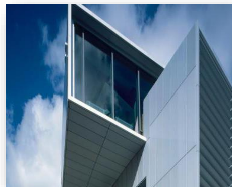
Façade en aluminium
