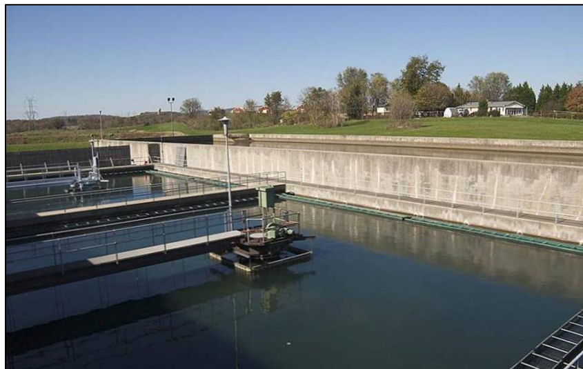
Figure 4. Procédé de coagulation-flocculation pour le traitement des eaux potables [4].
