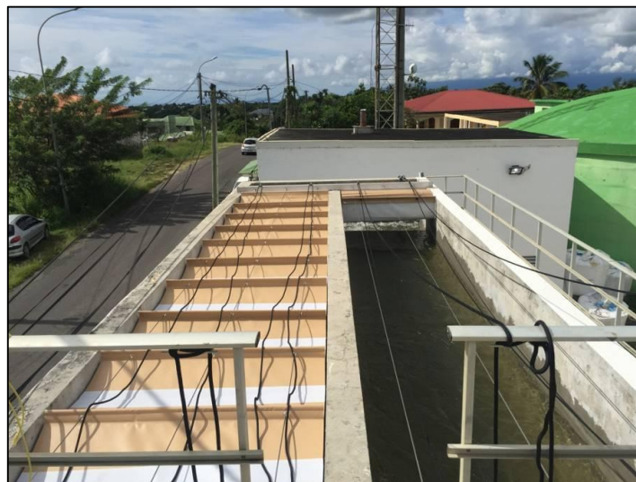
Figure 3. Procédé de dessablage pour le traitement des eaux potables [3].
