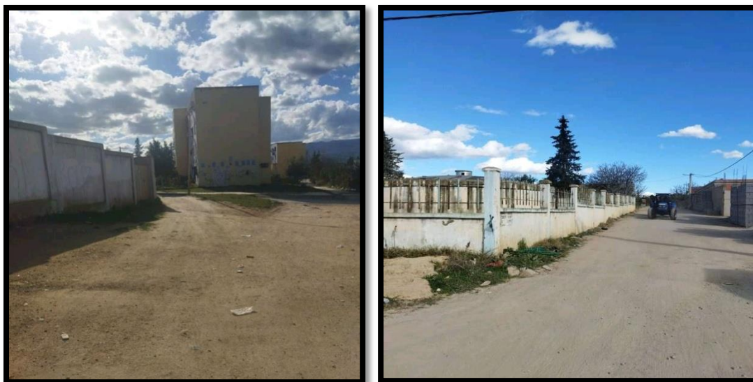
Figure24 : photo originale de la station de la cité Moumni Massoud
