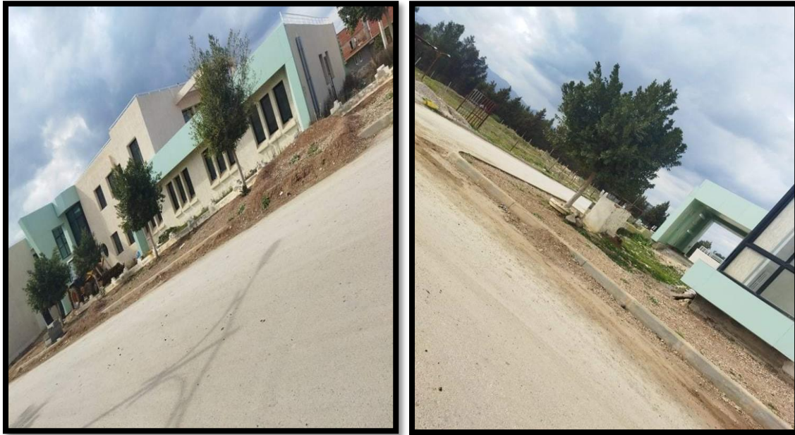
Figure28 : photo original de station L'hôpital de khizarra
