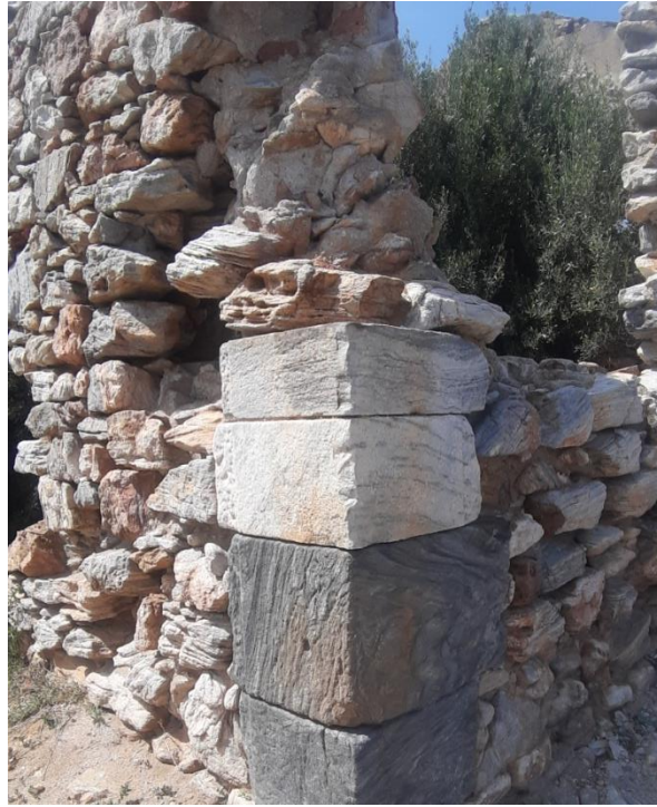
الصورة رقم 31: الحجارة الرخامية المستعملة في بناء زوايا المنشرة الفرنسية.
