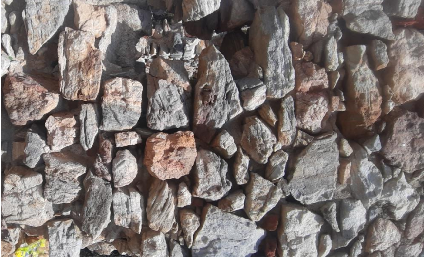
الصورة رقم 30: صورة لمواد وتقنية بناء المنشرة الفرنسية.
