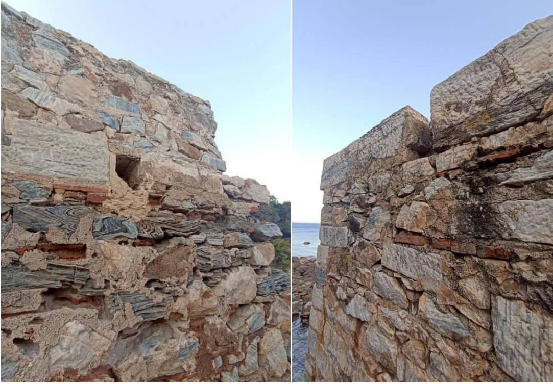
الصورة رقم 33: ثقوب تثبيت العارضة الخشبية الحاملة للسقف.
