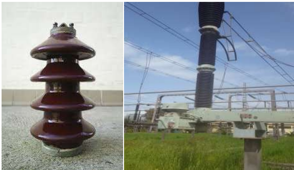
Figure I.2. Isolateur électrique en céramique destiné aux lignes électriques.
