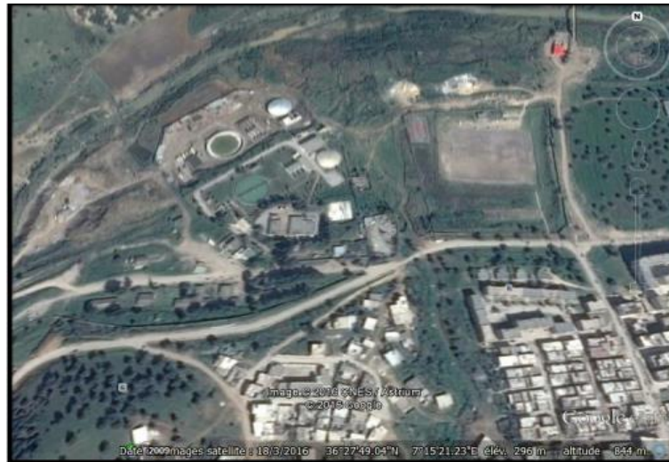
Figure. 5 : Photo satellitaire de la station de traitement de Hammam Debagh (Google Earth 2016).
