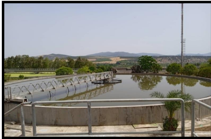
Figure II.5 : Décanteur primaire (STEP Guelma 2022)
