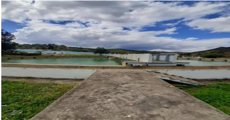
Figure I.3 : Bassin de décantation
