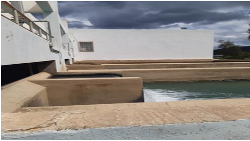
Figure I.4 : Filtration sur sable
