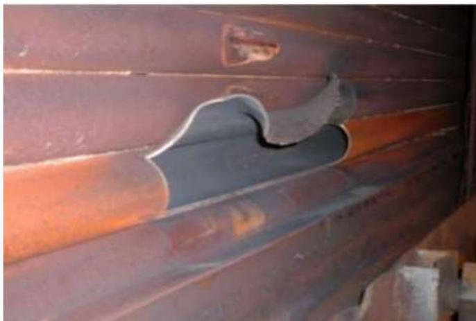
**Figure III.13 :** Phénomène de fluage causé par corrosion par fatigue.
