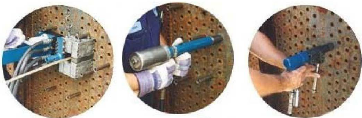
Figure I.13 : Nettoyage des tubes à l'aide d'un pistolet hydraulique .
