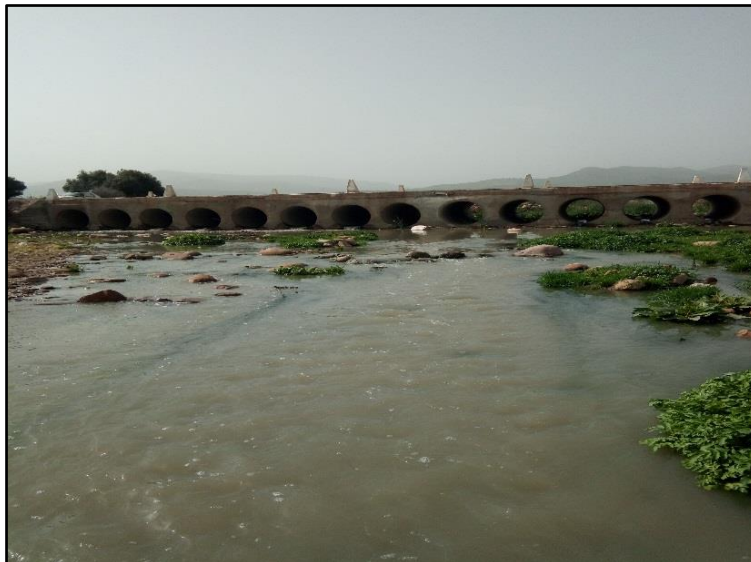
Figure 19 : Vu générale de la station 2(Lalaimia. I 2022).
