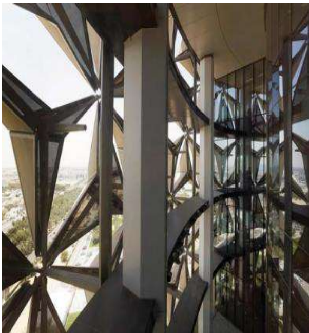
Figure 26: Vue depuis l'intérieur
