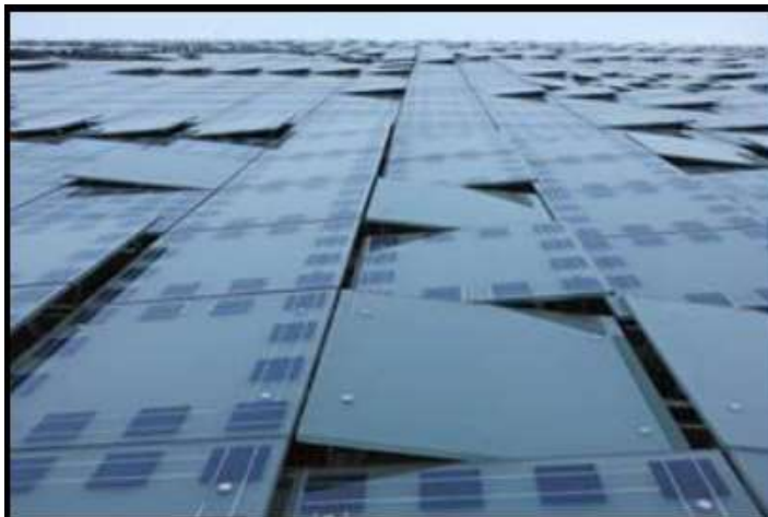
Figure 17: façade du bâtiment Greenpix et utilisation de cellules solaires
