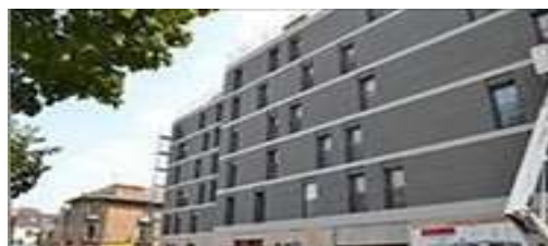
Figure 12 : Bâtiment BBC "la Barbotière" situé à Rennes http://www.toutsurlisolation.com
