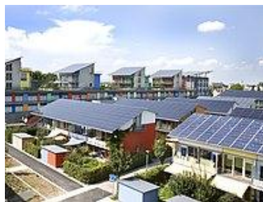
Figure 14: énergie solaire photovoltaïque: panneaux solaires intégré en toiture,
